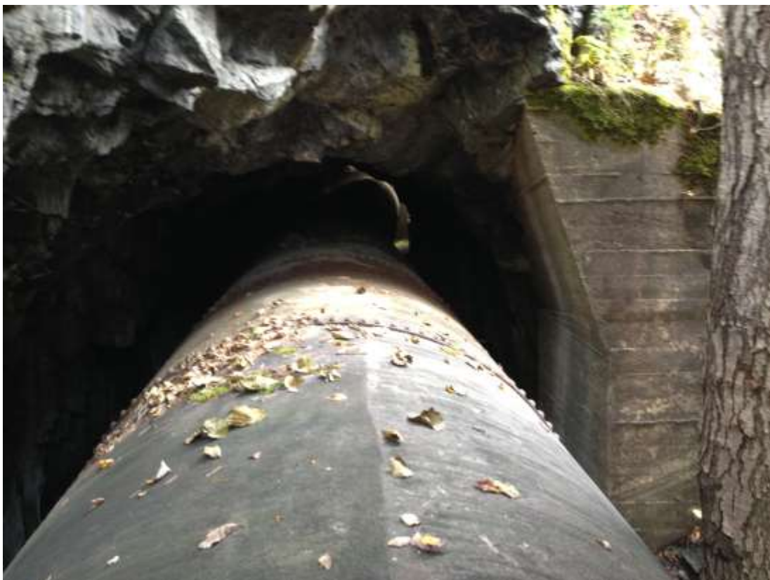
Bilde 16: Viser tunnelinnhogg der rørgaten går i gjennom. Foto: Rolf Amundsen Denne tunnelen vil ikke benyttes i forbindelse med det nye anlegget.
