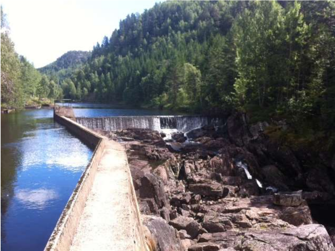
Bilde 15: Viser dam og inntak. Litt større vannføring enn slukeevnen Foto: Rolf Amundsen
