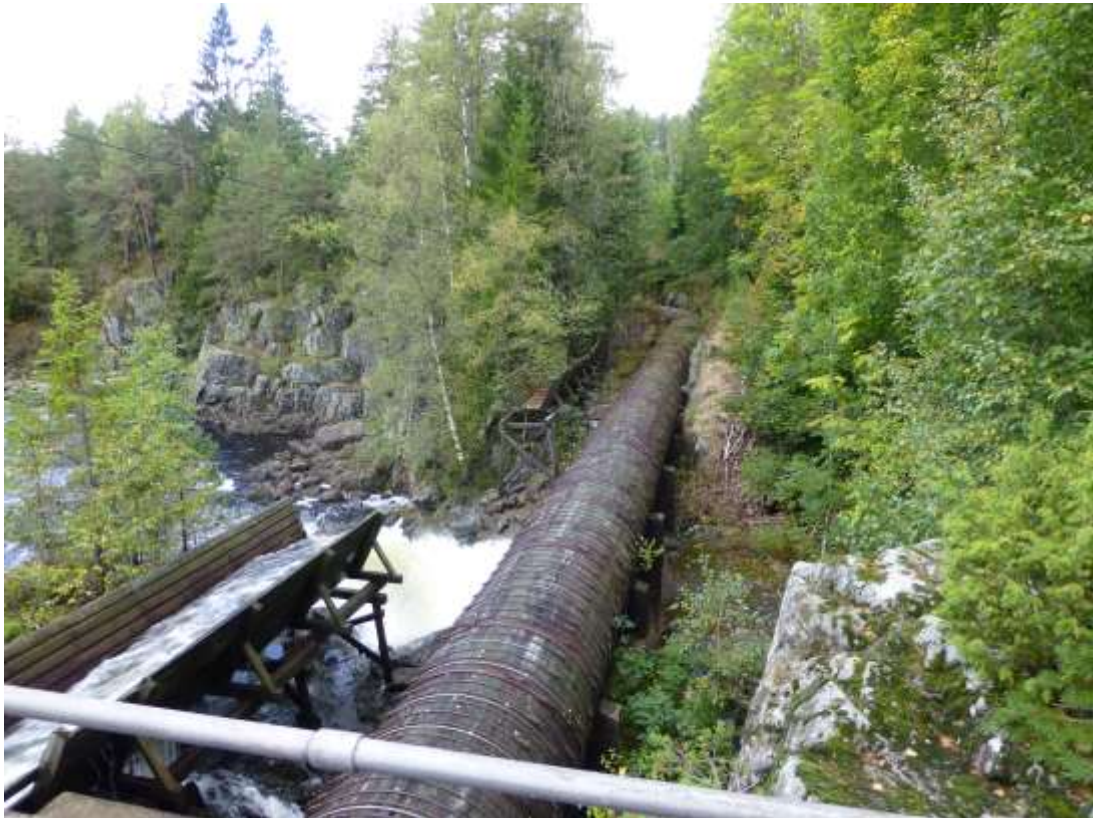
Bilde 9: Viser rørgate i dag fra inntak. Foto: Rolf Amundsen
