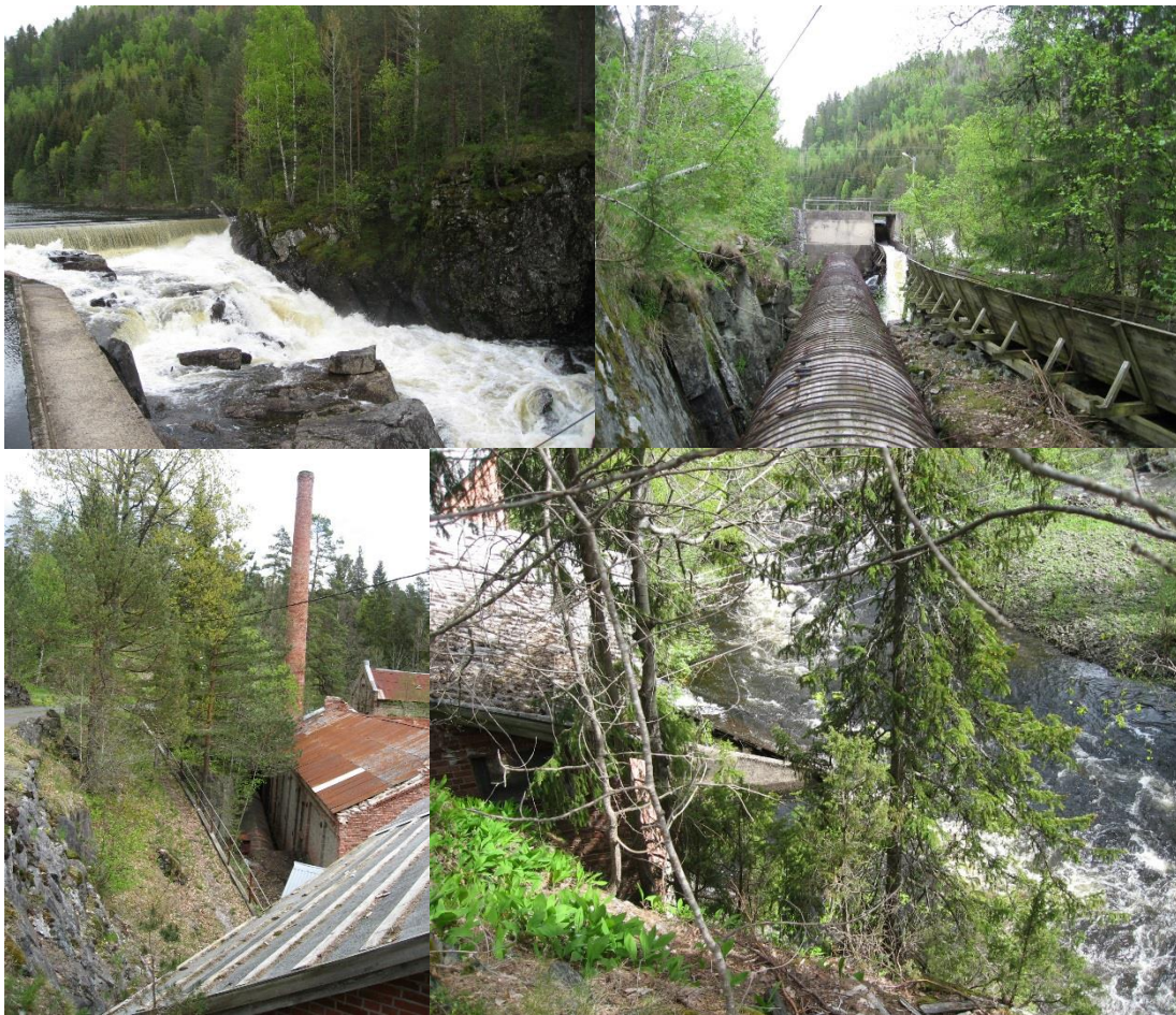
Figur 2-1. Bilde øverst i venstre panel viser dammen med rester av fossesprøytsone. Bilde øverst i høyre panel viser eksisterende rørgate med tømmerrenne og inntak ved dam. Bilde nederst i venstre panel viser industribyggene med kraftverket i forgrunn og rør samt Stifossveien. Bilde nederst i høyre panel viser eksisterende utløp fra dagens kraftverk.
