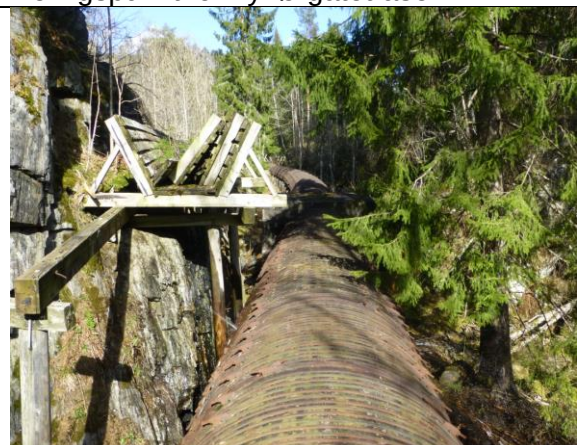
Anleggsvei vil krysse rørgate om lag midt i bildet og omtrent ved klossen. Foto: Rolf Amundsen
