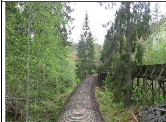
Rørgatetrase sørover mot industribyggene
