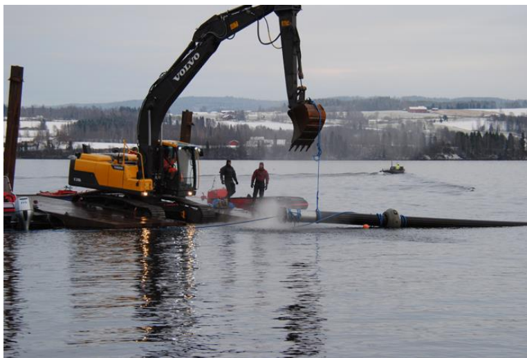
Figur 4-2. Legging av ledning fra lekter i Mjøsa. Foto: Østlandet plast og dykk AS.
