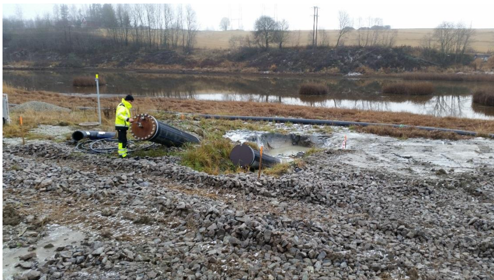
Figur 5-3. Vannledning gravd under Nitelva ved Hvam vinter 2016 og viser området for kum.
