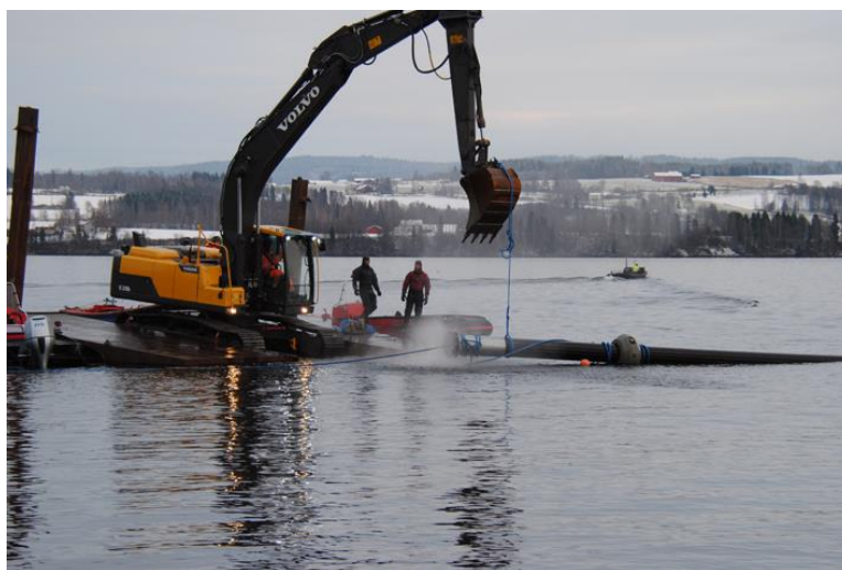
Figur 5-2. Legging av ledning fra lekter i Mjøsa. Foto: Østlandet plast og dykk AS.
