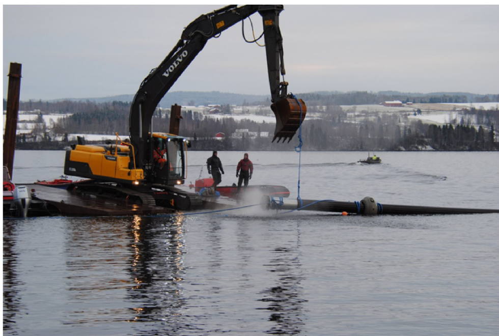
Figur 2 Legging av ledning i Mjøsa. Foto: Østlandet plast og dykk AS
