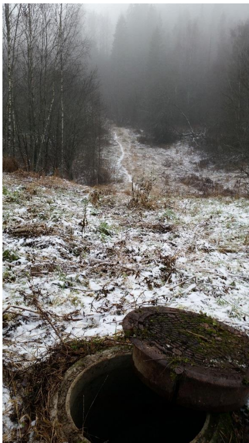
Figur 16. Kum ved Holm på vestsiden. Bildet viser sti/anleggsvei ned til kum.
