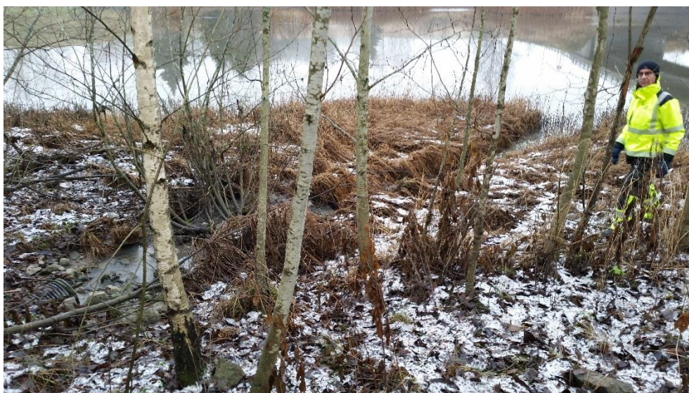
Figur 10. Området på nord og vestsiden av Åros bru hvor vannledningen skal inn på land.
