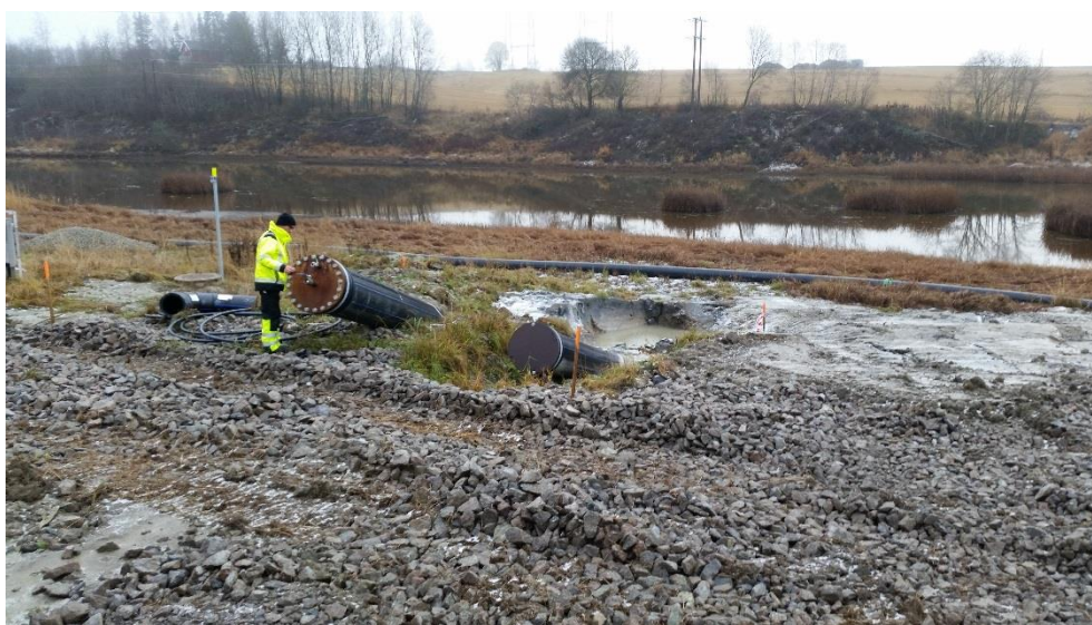
Figur 6. Bildet viser vannledning som er borret under Nitelva og kommer opp på østsiden. Nitsund gård i bakgrunnen.
