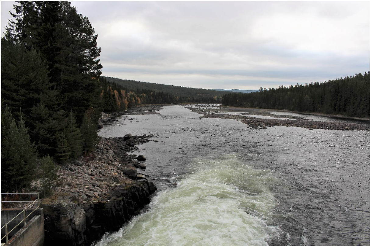
Glomma ved Høyegga 29.09.2017. Vannføring på 15,0 m 3 /s forbi dammen
