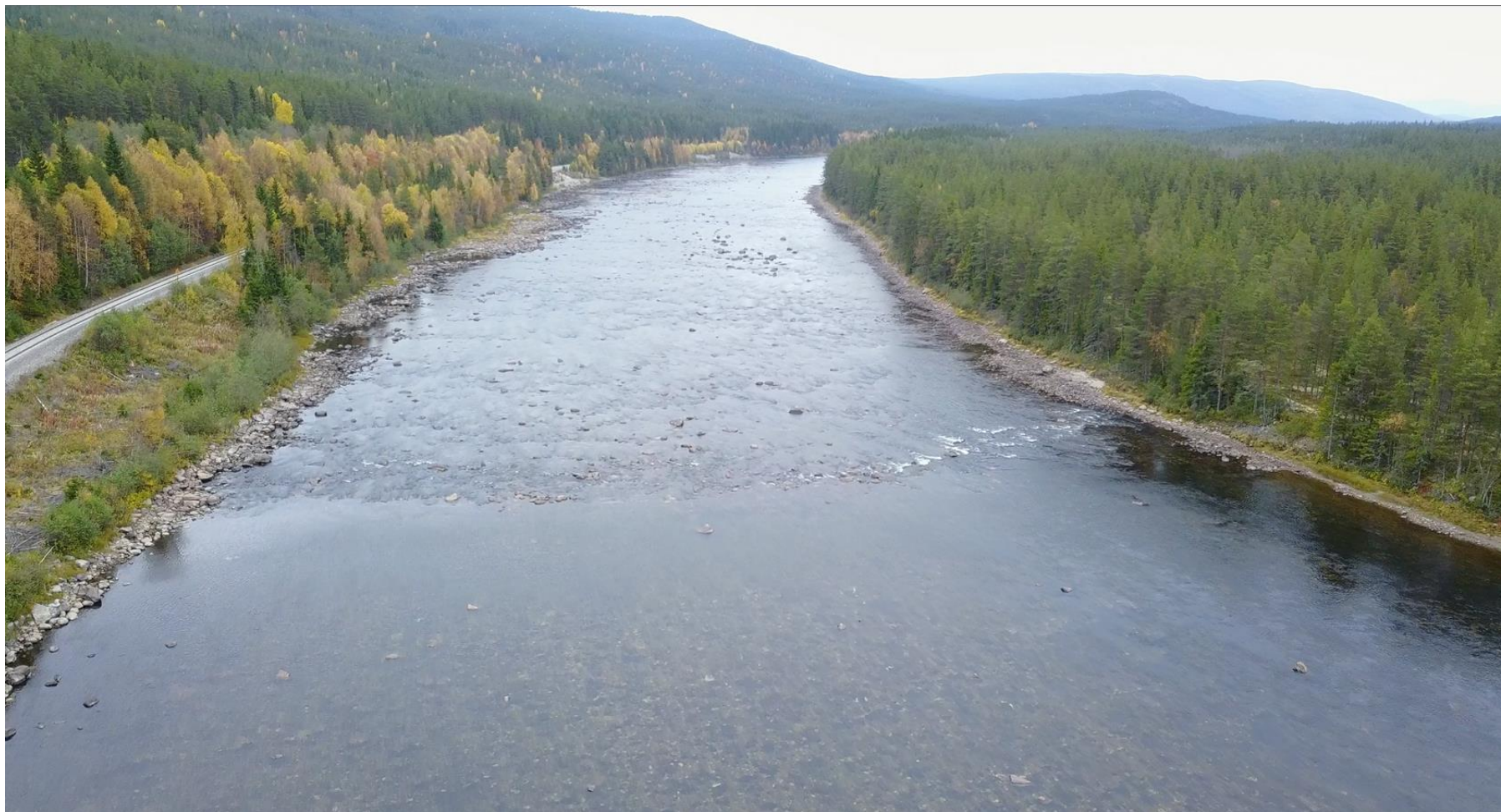
Glomma ved Barkald jernbanestasjon (bunnterskel bygd ved Torskelforliket)
