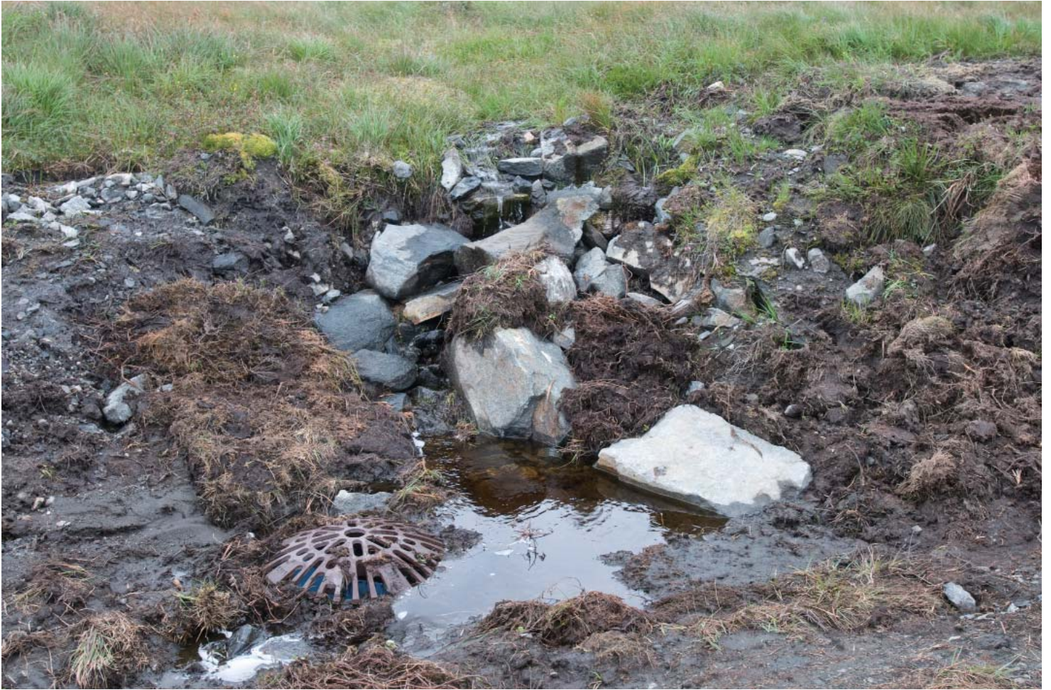
Drenskum kan være fordelaktige med tanke på kontroll over håndtering av overflatevann.
