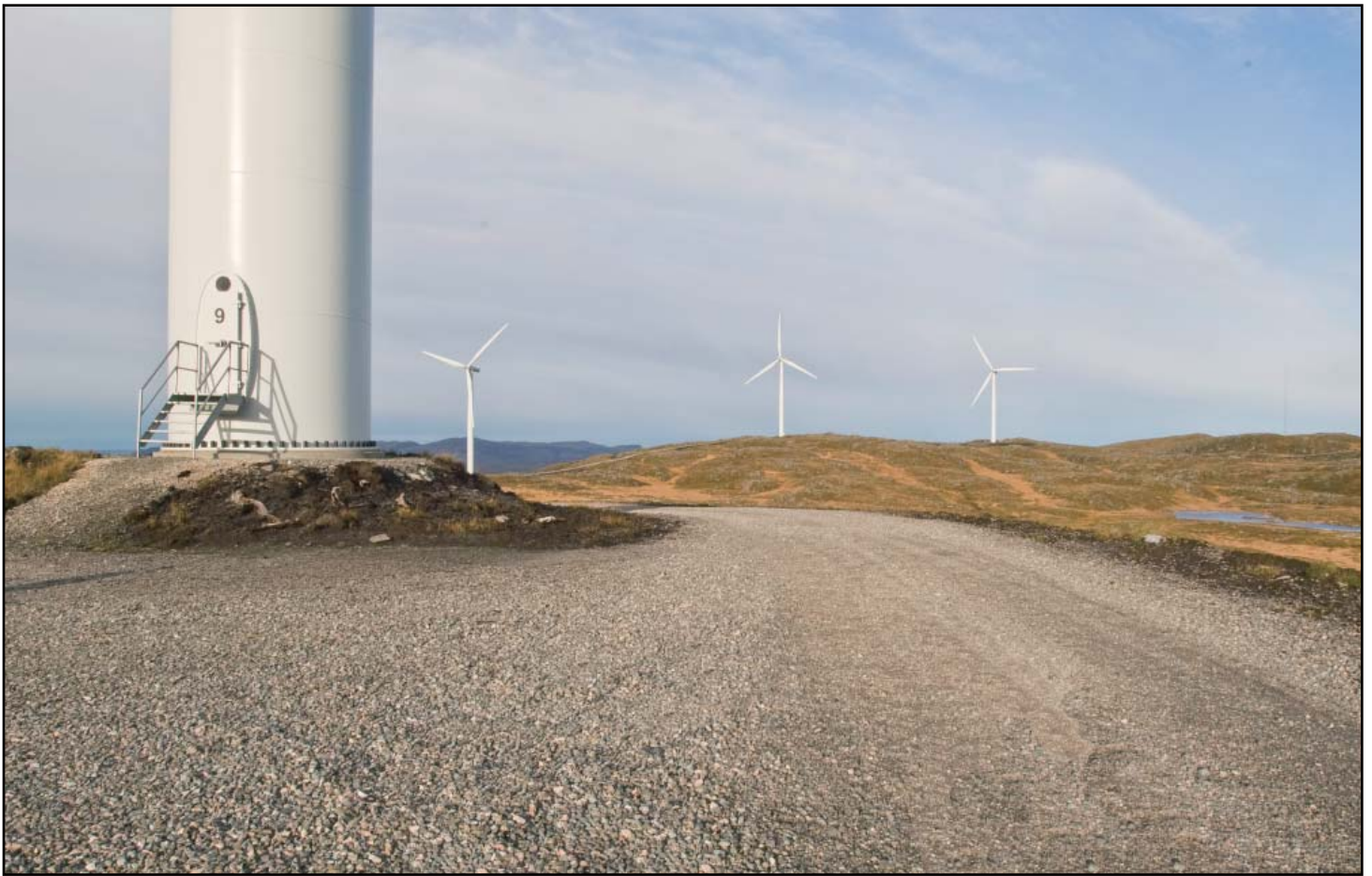
Turbinfundamentet er hevet ca. 1 meter over kranoppstillingsplassen, og gjør at det har dårlig visuell forankring i plassen.
