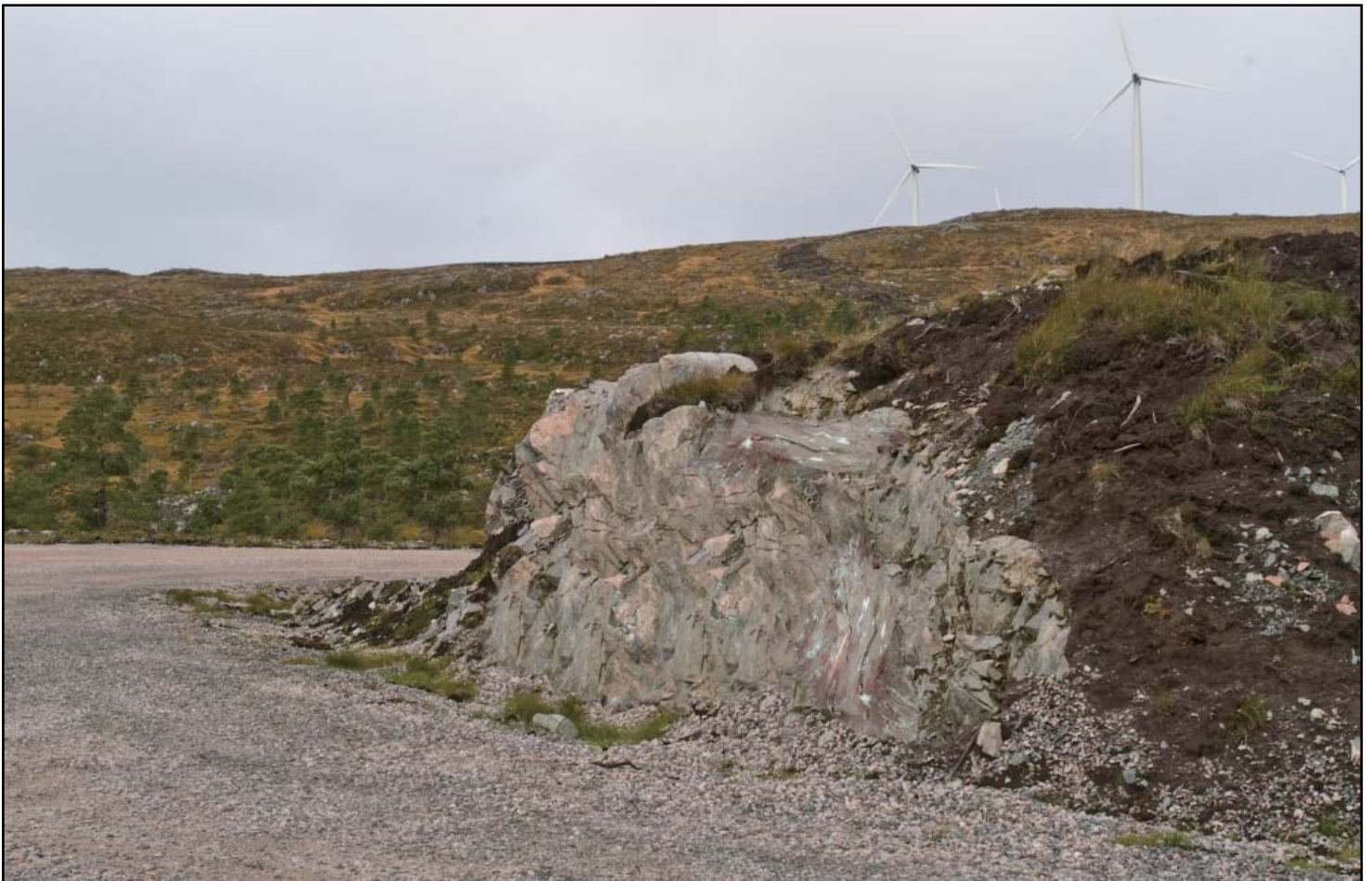
Fjellskjæring uten tiltak.
