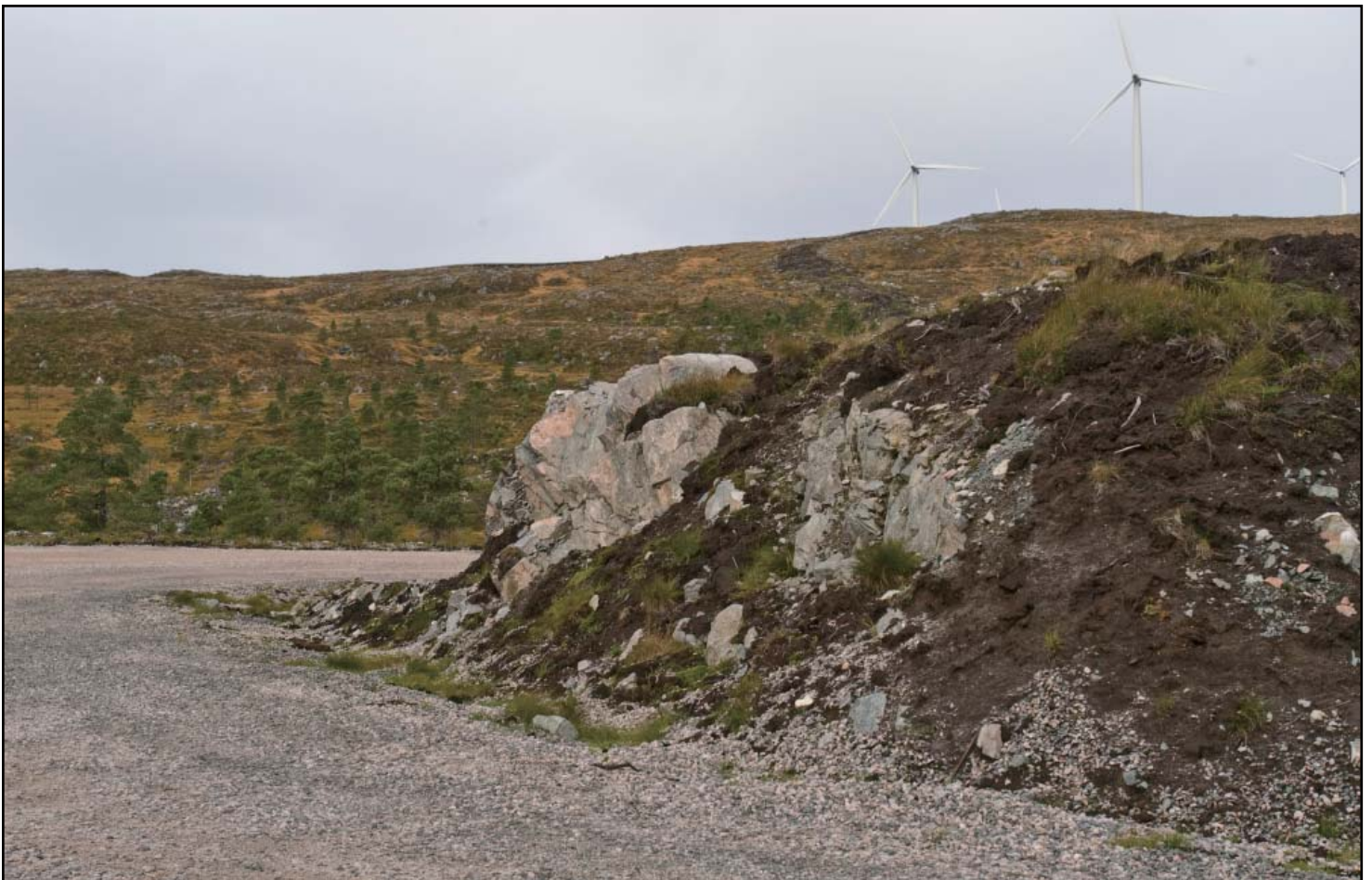
Jordmasser er trukket ned fra toppen og inn i foten av skråningen, og gir fjellskjæringen bedre landskapstilpasning og visuell forankring.
