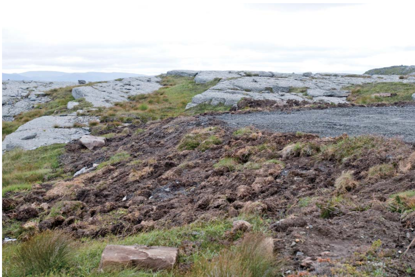
Nylig utlagt torv i kanten av kranoppstillingsplass. Torva er ikke klippet til og på sikt vil det gi raskest reetablering av vegetasjon.
