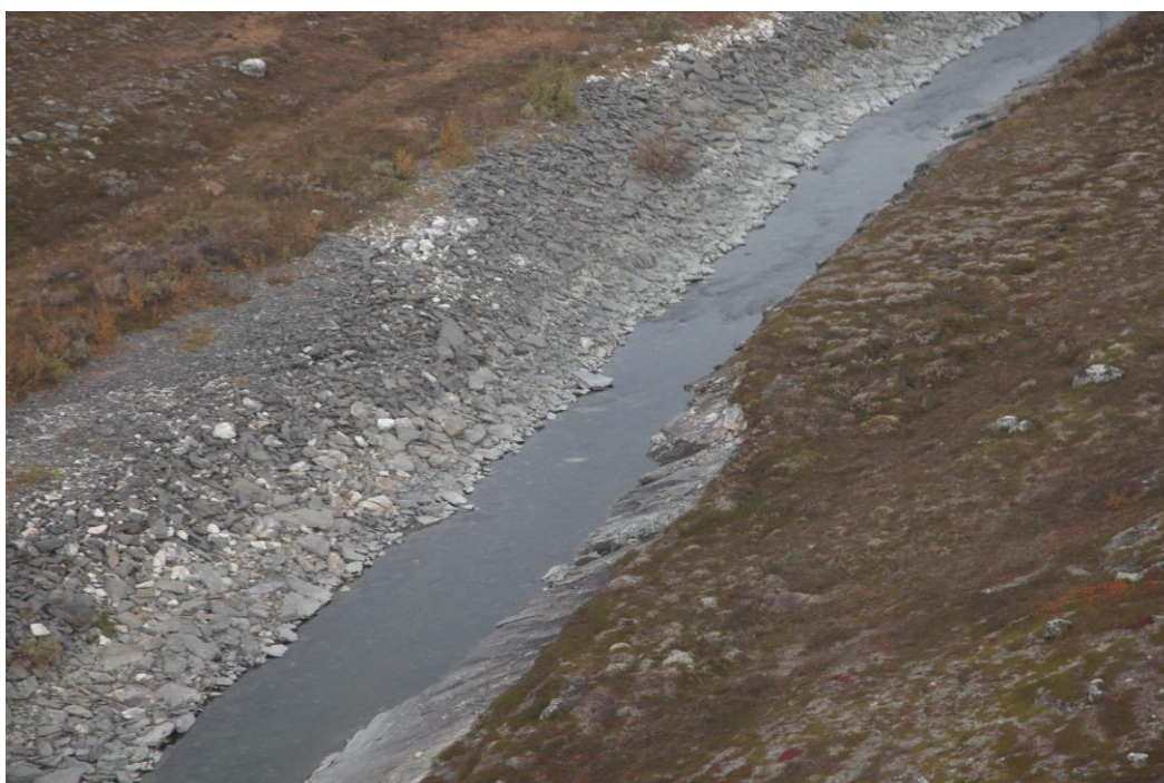
Bilde 2 Utsnitt fra Roggekanalen som viser plastring og profil typisk langs en vesentlig del av kanalen.
