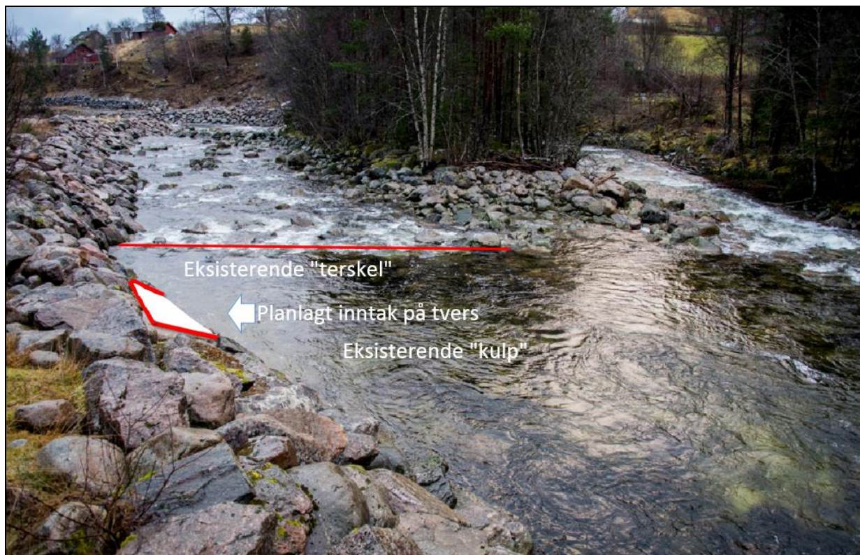
Figur 4. Planlagt inntak i eksisterende 1 m dyp kulp i elven, bak eksisterende terskel i elvens vestre løp. Det blir ikke behov for noen nye «inngrep» i elvestrengen.
