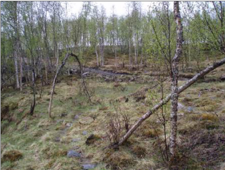
Bilde 2.3: Bilde av anleggsvei som komme inn øverst i rørtråse.
