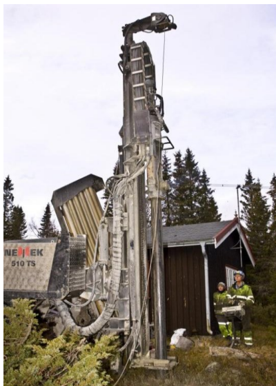
Fig. 4 Boring av brønn
