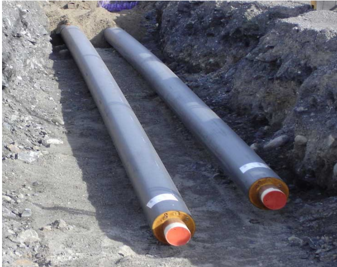
Figur 5, Fjernvarmerør fra bygging
