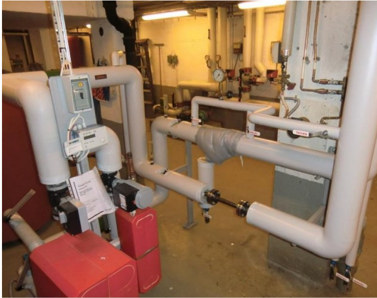
Figur 1, Eksempel på kundesentral med vekslere for varmt tappevann og oppvarming.
