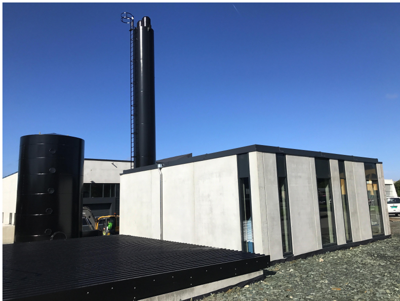
Flismagasin underbakken og akkumulatortank til venstre - Bygg for flisfyr til høyre. Pipe i bakkant.
