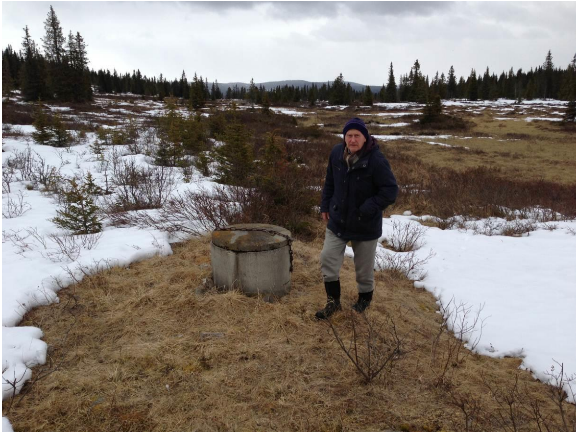
Bilde 5.1 Fra inntak ca kote 755 moh og ned med ventil kum
