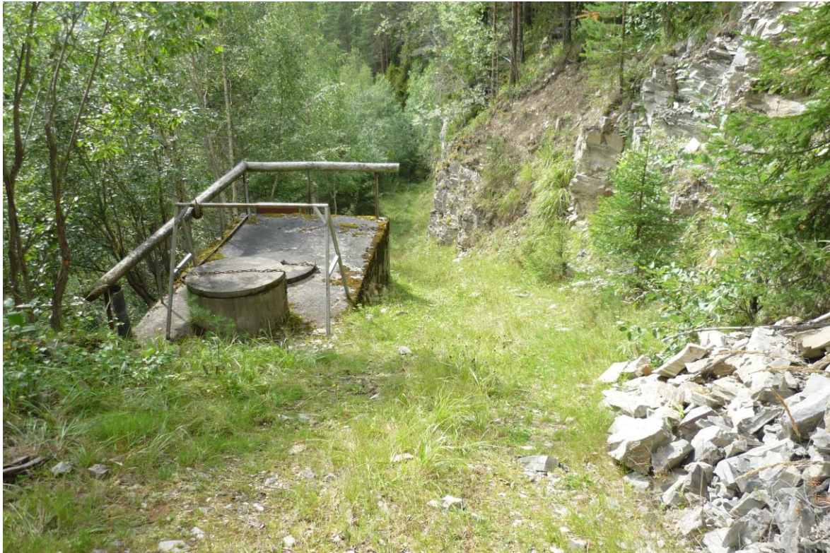
Bilde 5.5 Vei & rørgate ca kote 640 moh
