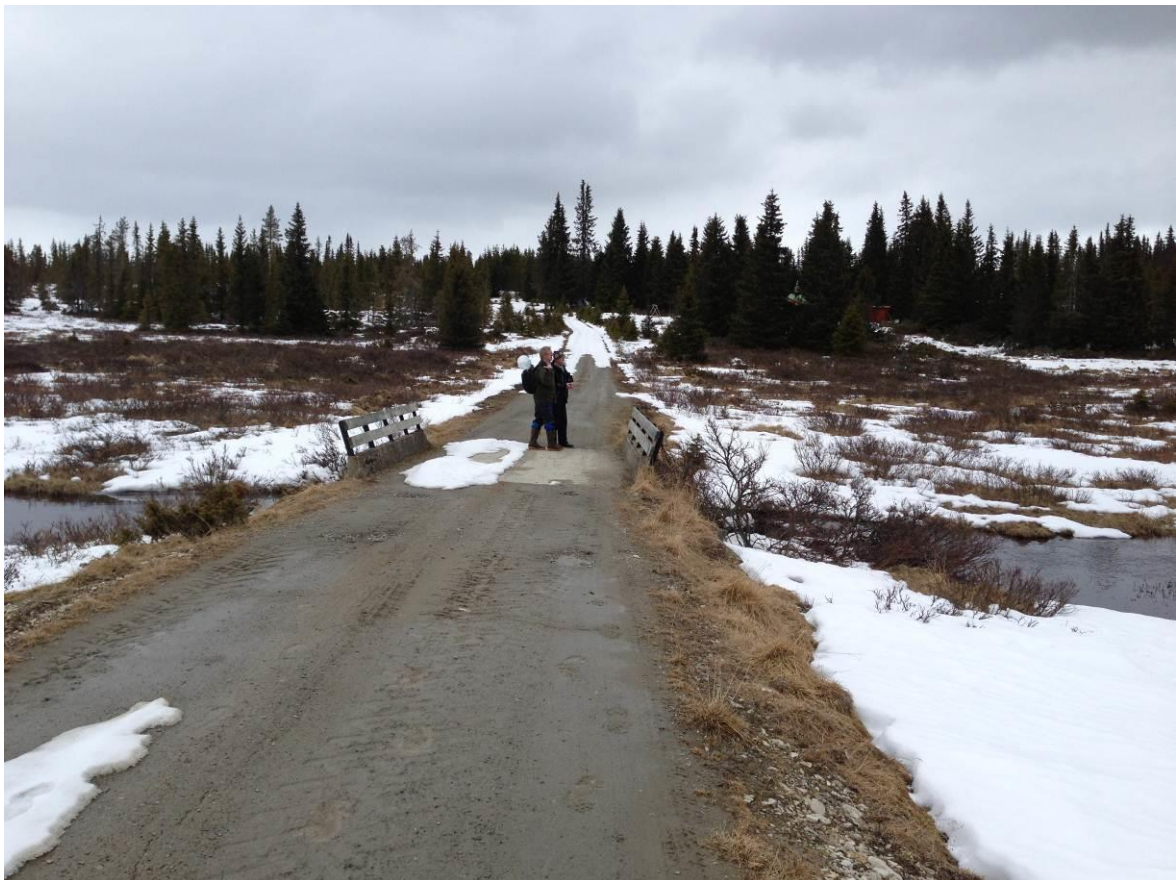
Bilde 2.2 Myrseterbekken krysser veien ca kote 753 moh
