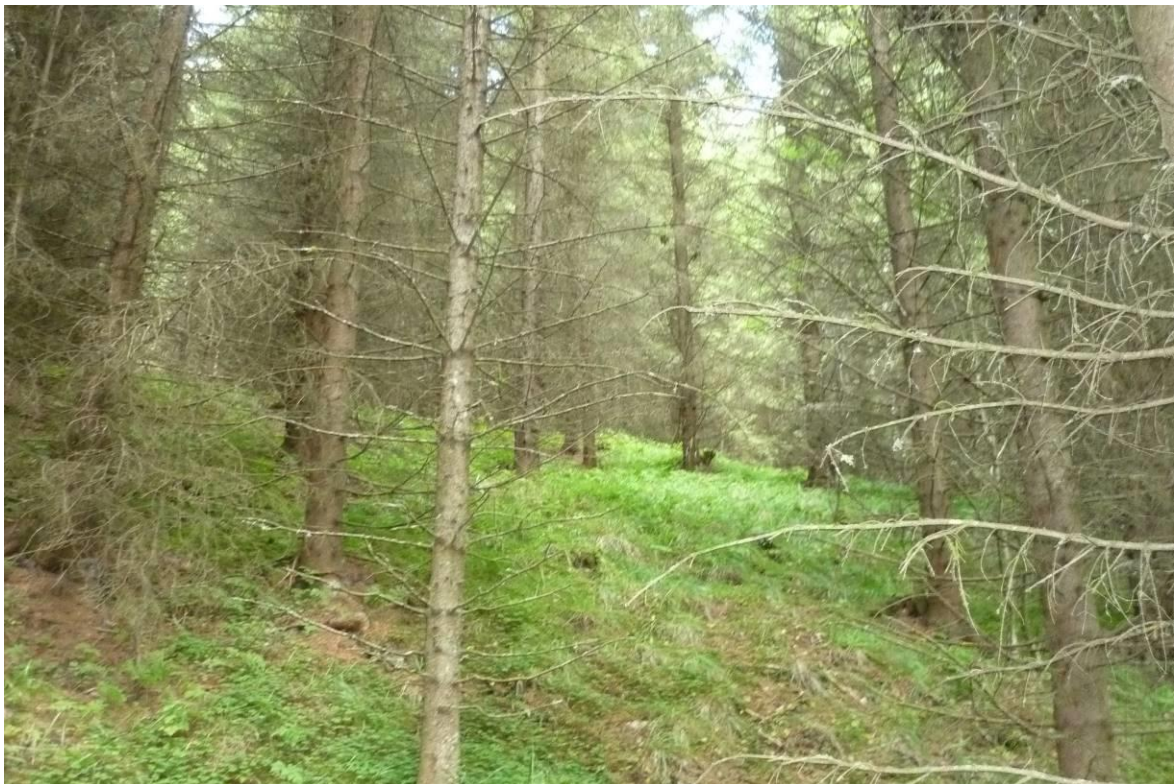
Bilde 5.8 Ny rørgate i skog ca kote 370 moh
