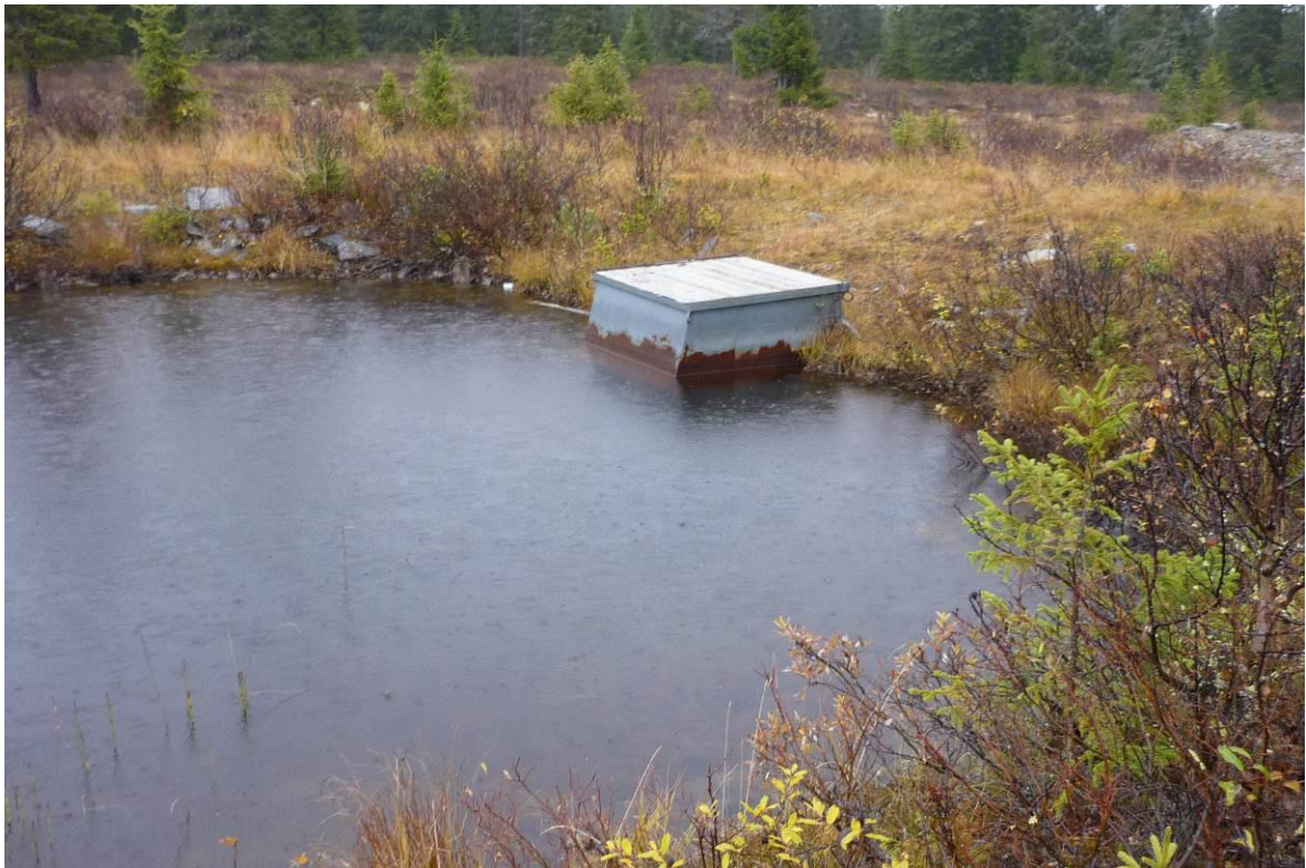
Bilde 1.2 Inntak ca kote 755 moh inntaket
