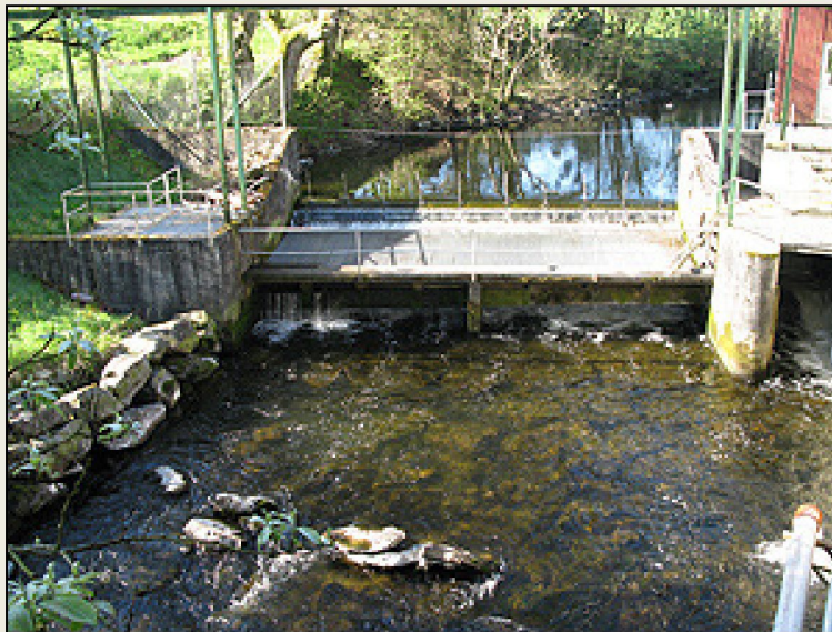
Felle for å hindre passering av laks.
