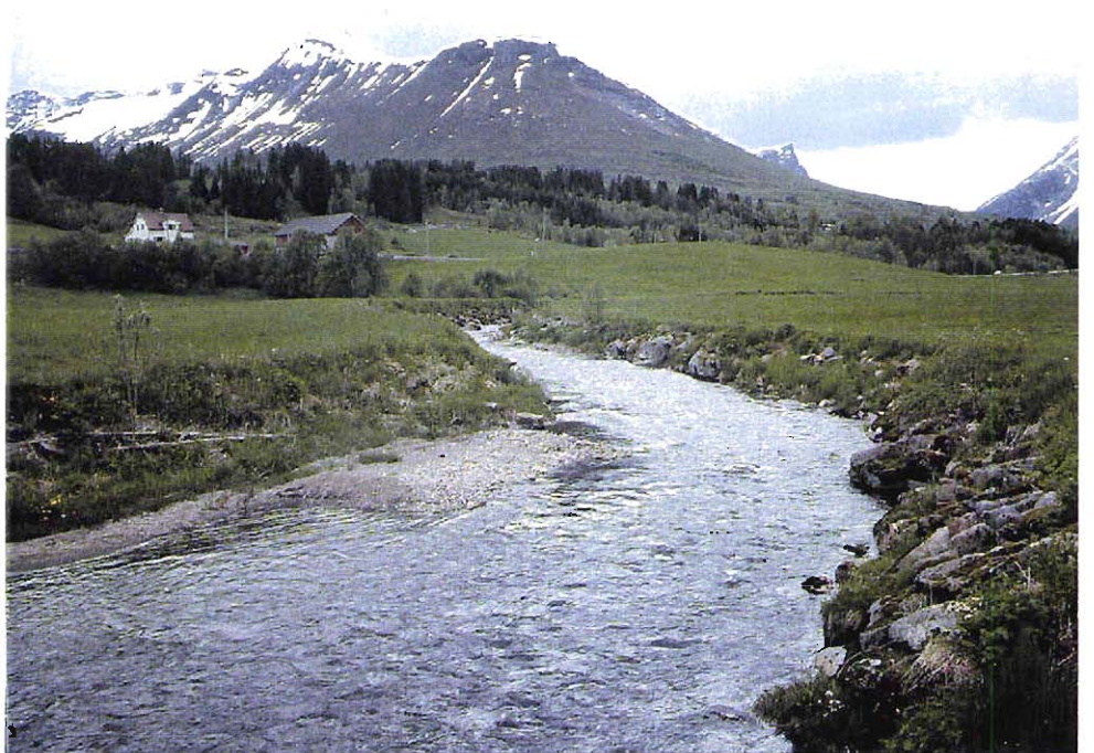
Gammel forbygging ved Rekkedal
