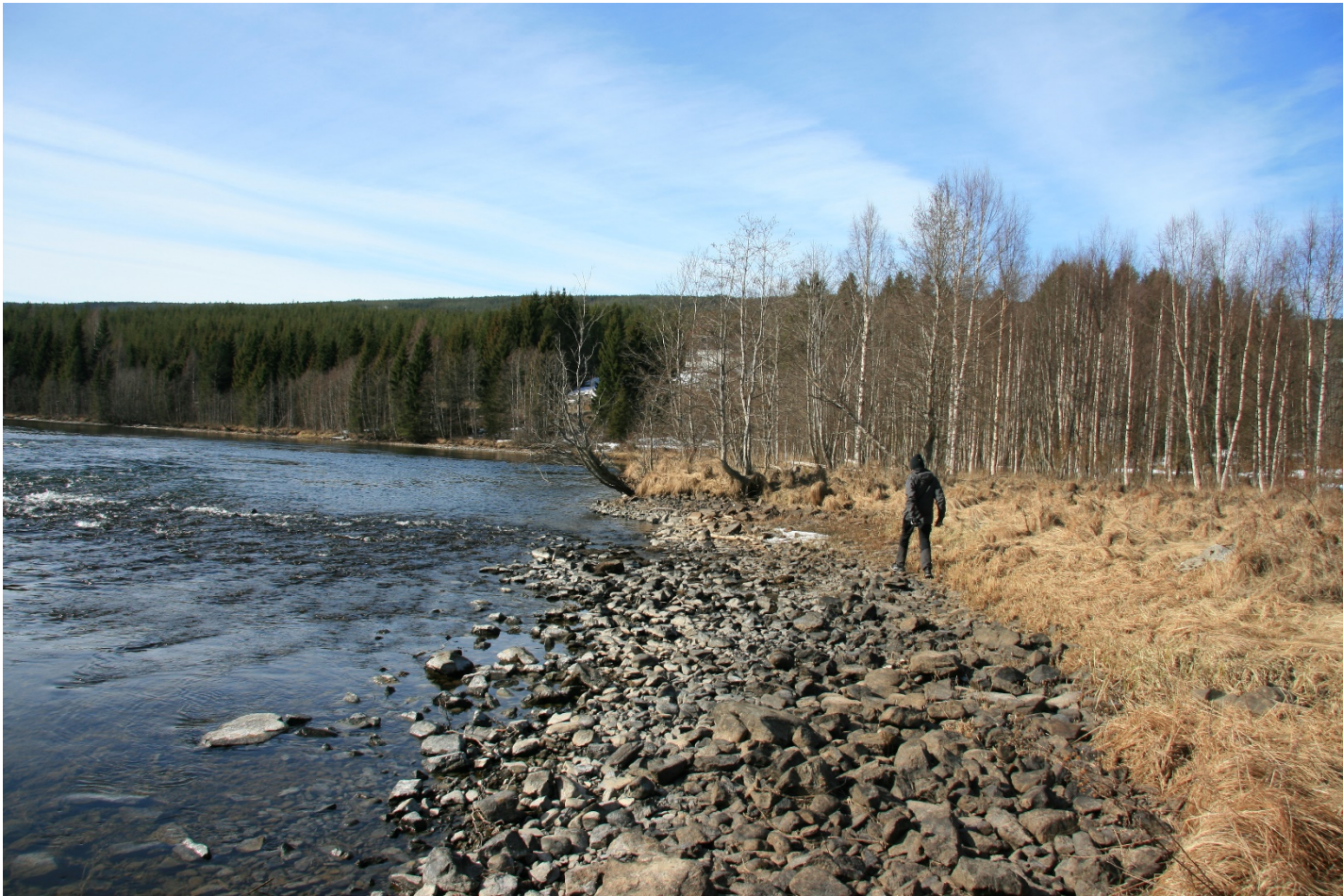
Terskelens nordre landfeste. Adkomstveg anlegges gjennom skogen til høyre i bildet.
