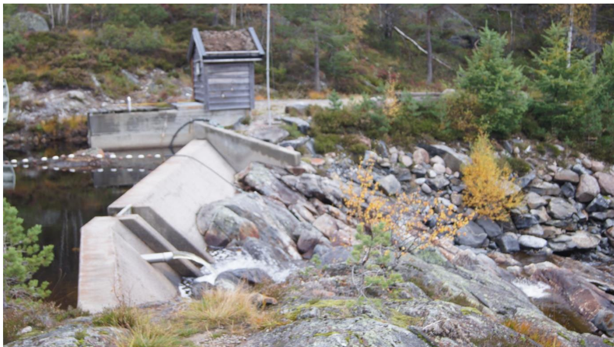
Figur 4. Dam og inntak til Storebekk kraftverk.
