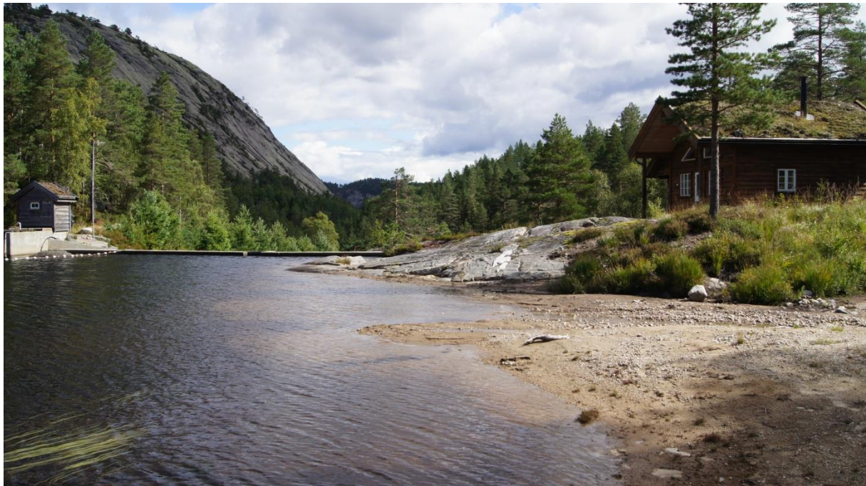
Figur 7. Eksisterende dam sett ovenfra. Damhytte sees til høyre på bildet.
