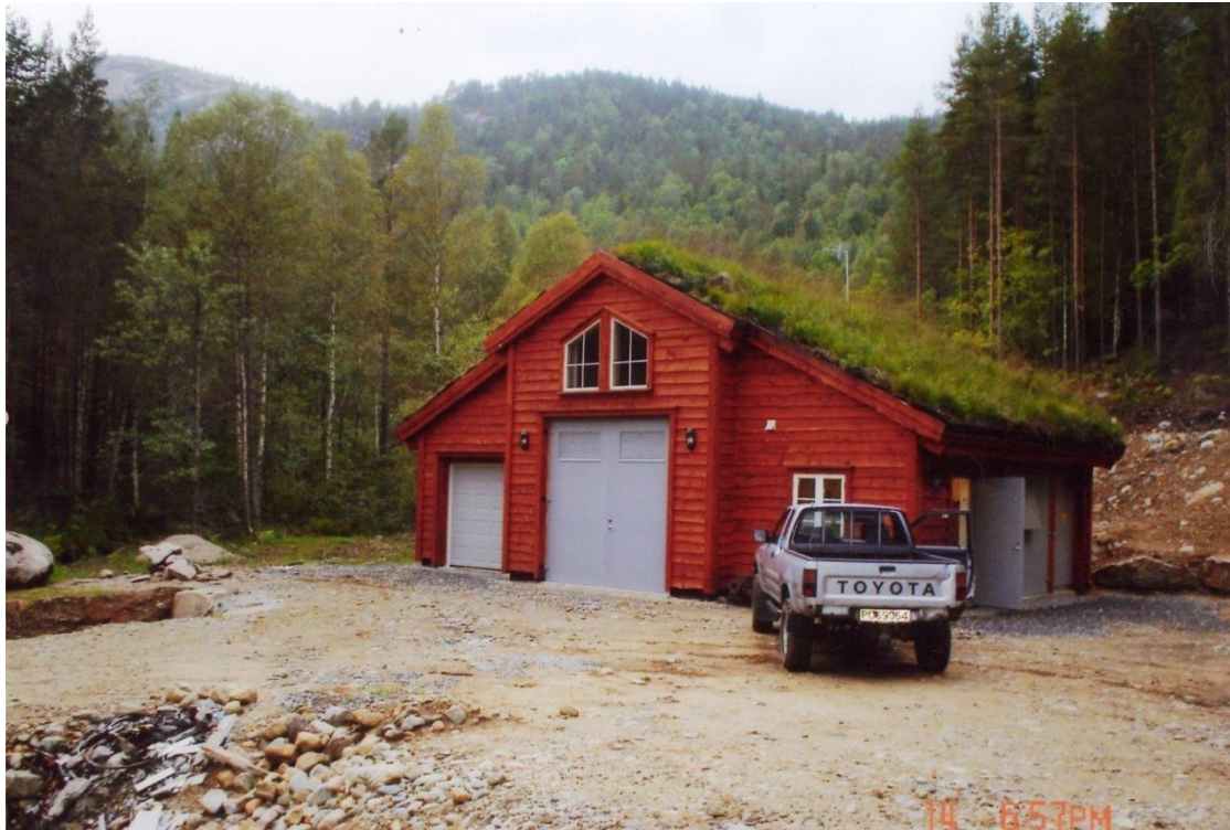
Figur 17. Storebekk kraftstasjon, bilde tatt i 2005.
