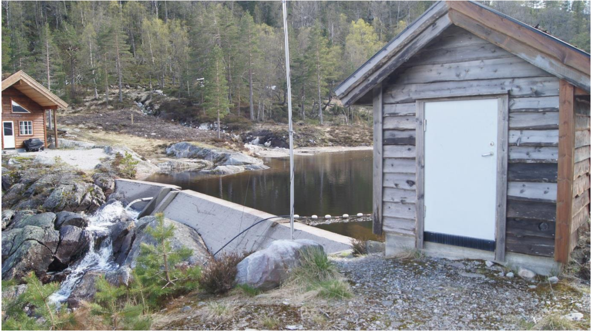
Eksisterende dam/inntak gravitasjonsdam/terskedam
