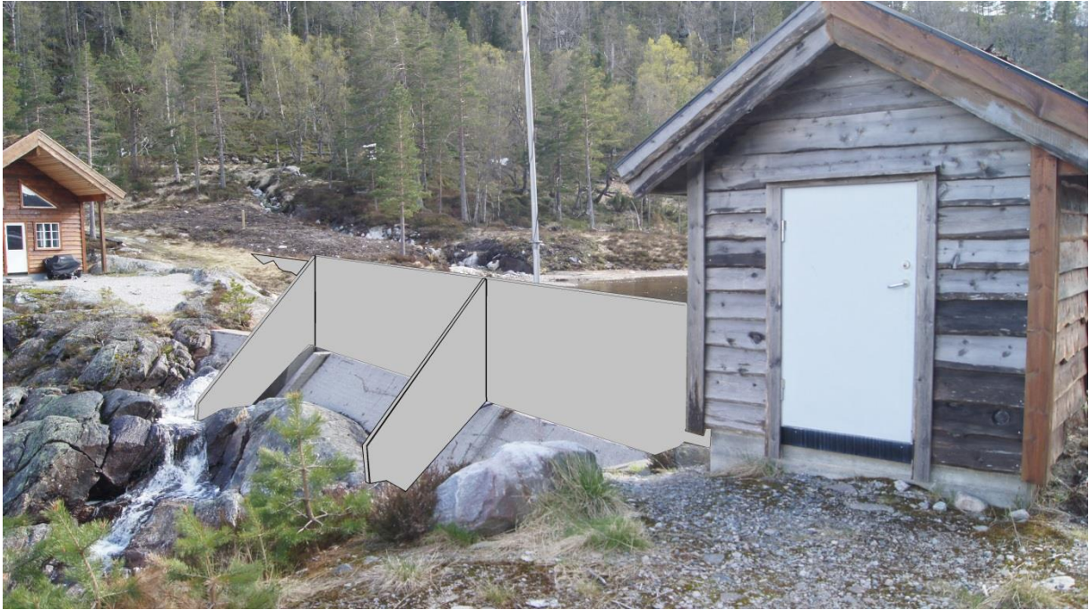
Dam med 2 meter regulering og plate dam
