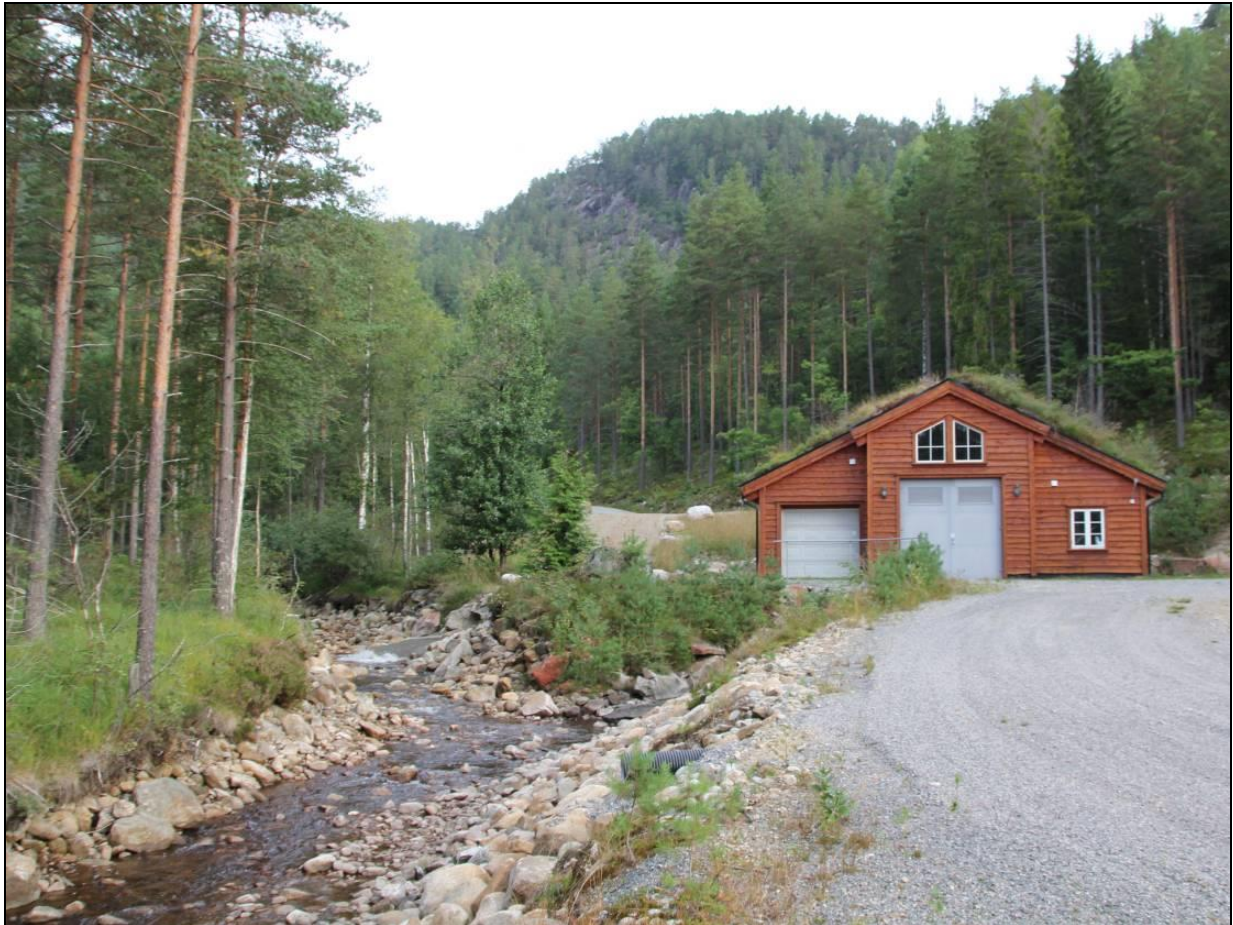
Figur 6. Storebekk kraftverk har utløp på kote 200.
