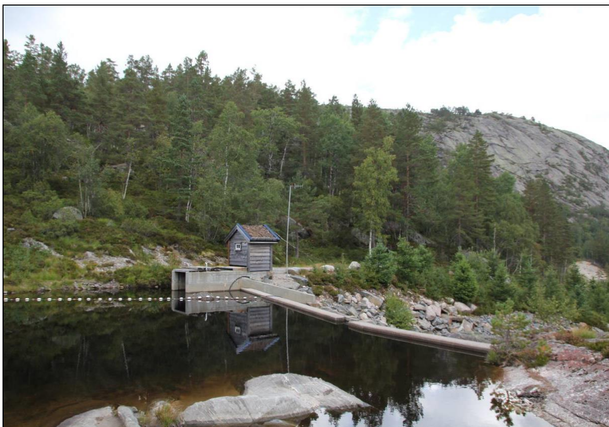
Figur 5. Inntaksområdet til Storebekk kraftverk kote 479.
