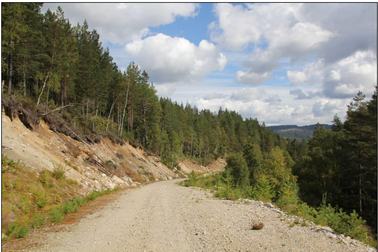
Figur 7. Tilkomsvei til inntaksdammen til Storebekk kraftverk.
