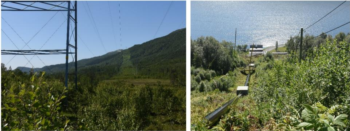
Figur 8-3 Til venstre: Dagens linje sett vestover fra planlagt riggområde ved kryss fv.829/E10. Til høyre: Vegetasjonsbilde ved planlagt trafo ved Niingen i Bogen. Foto: Sweco Norge.
