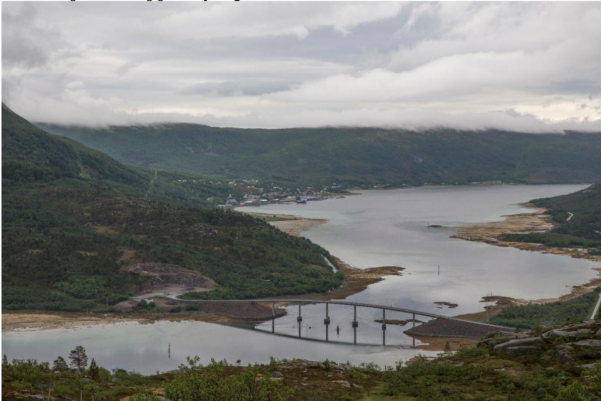
Figur 4-11 Ramsundbrua ligger der sundet er på det smaleste og samtidig skifter retning. Den varierte landformen og det trange sundet med mange gruntvannsområder forklarer landskapet på en svært tydelig måte. Foto: Sweco Norge AS v/Marius Fiskevold.
