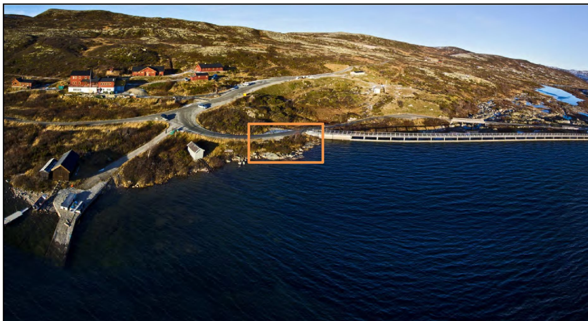
Figur 3.13 Ved Kalhovd Turisthytte. Området for utløpet av overføringen i Kalhovdmagasinet er markert.
