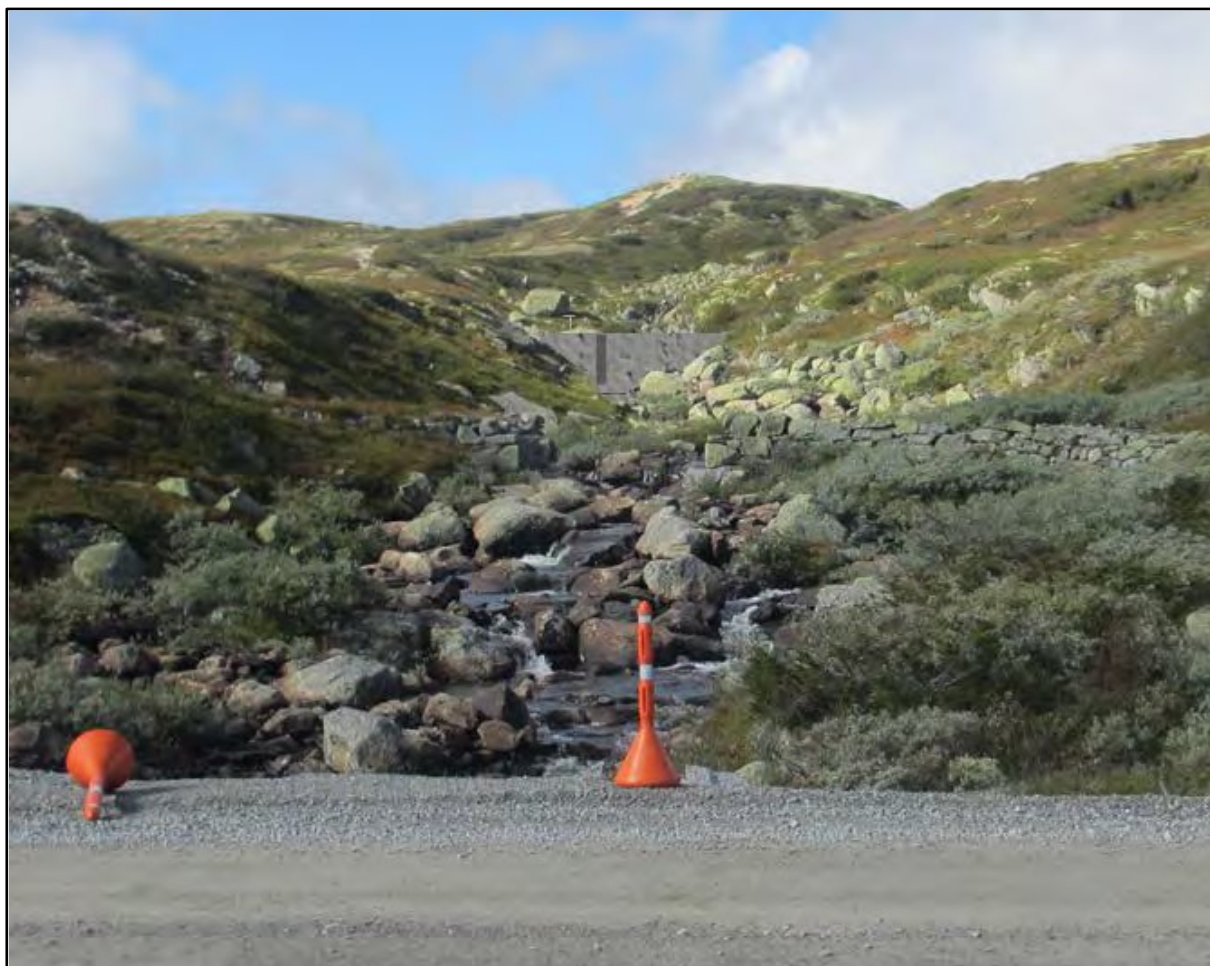
Figur 2.6 Et fotomanipulert bilde av inntaksdammen sett fra veien (det er her den sees best). Dammen sees midt i bildet
