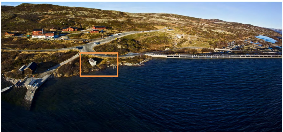
Figur 28. Ved Kalhovd Turisthytte. Området for utløpet av overføringen i Kalhovdmagasinet er markert.
