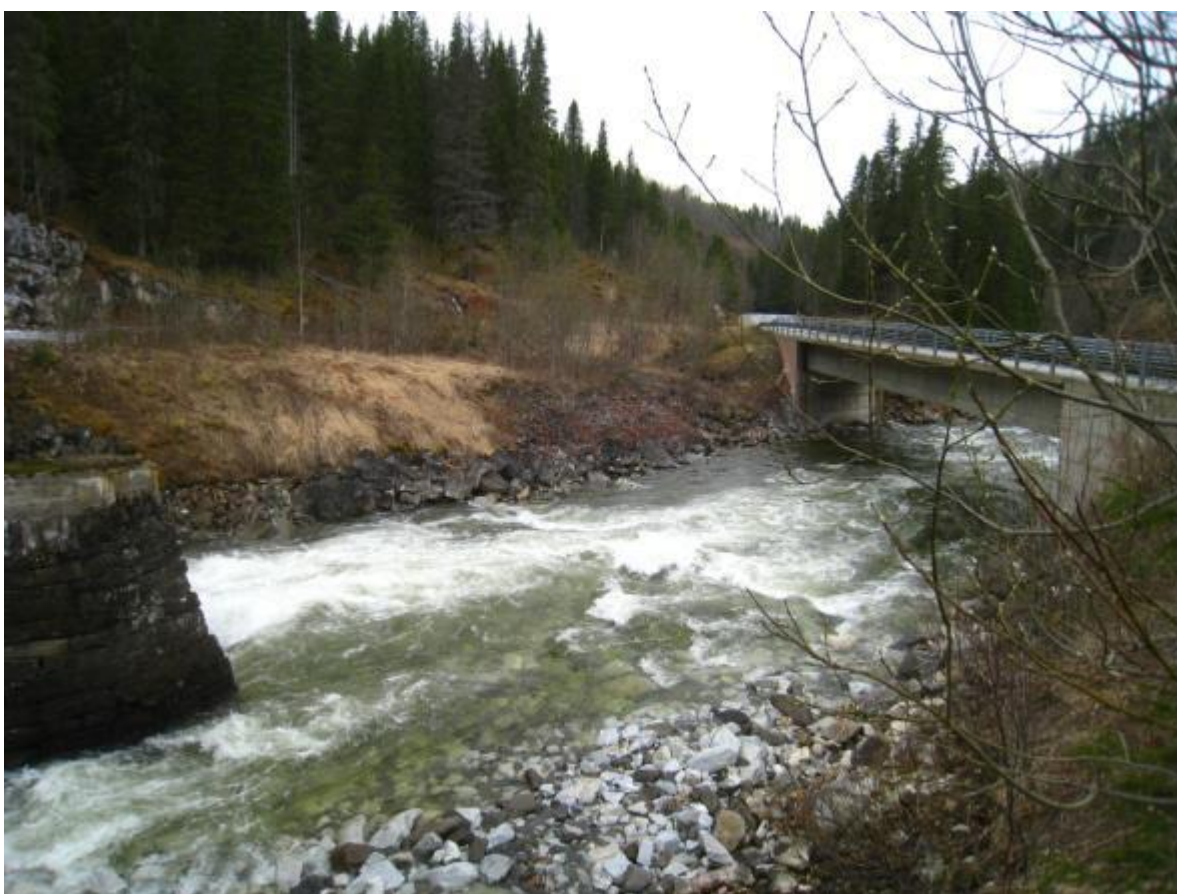
Figur 18. Fv. 357 i bru over Grønfjellåga. Gammelt brufundament tv.
