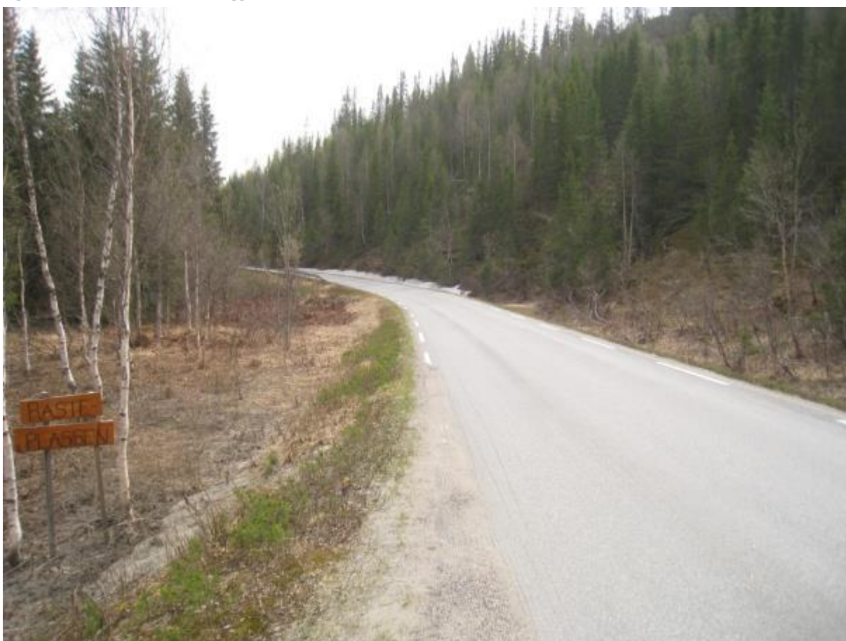
Figur 29. Område for avkjøring til kraftstasjon ved rasteplassen ved Austervollen.
