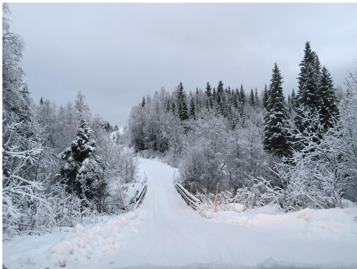
Figur 2 Stupformoveien bru. Kabeltrase langs vei
