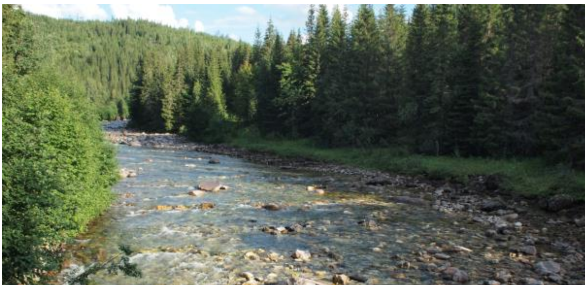
Figur 32. Utløpskanal fra kraftstasjonen munner ut midt i bildet.
