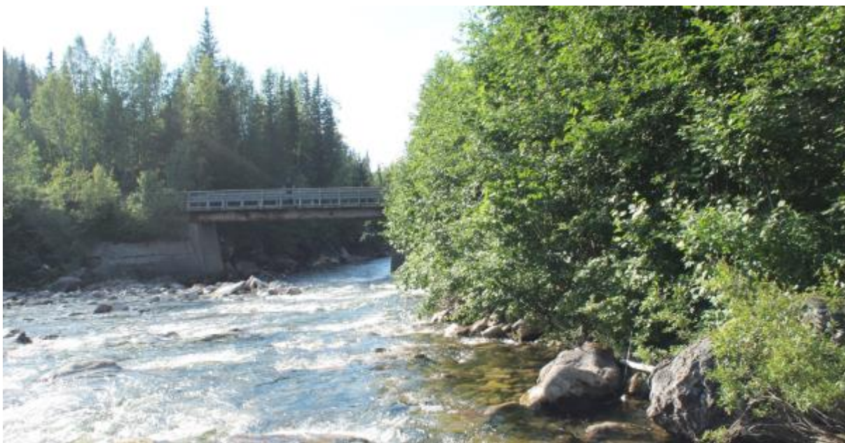
Figur 34. Stupformobrua. Nedstrøms utløpskanal.
