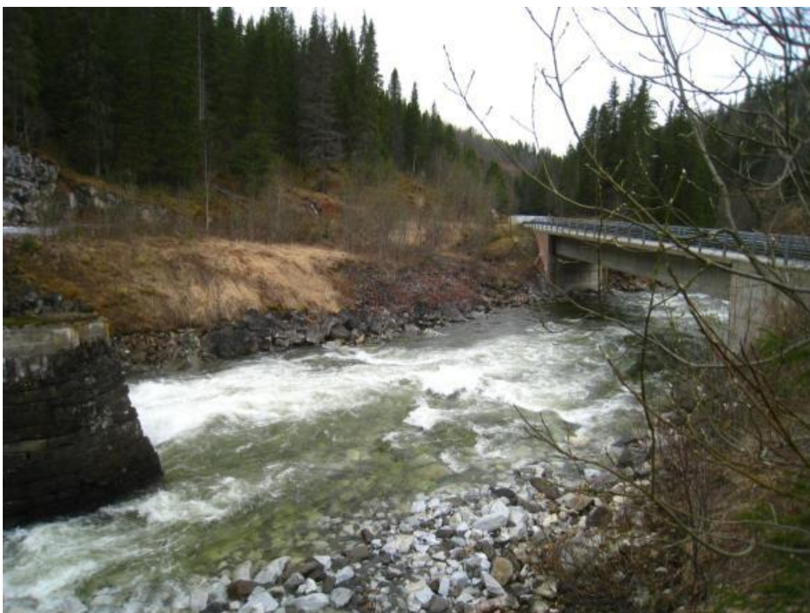
Fv. 357 bru over Grønfjellåga. Gammelt brufundament tv.
