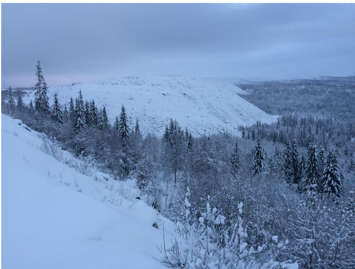
Steintipper ved Ørtfjell trafostasjon
