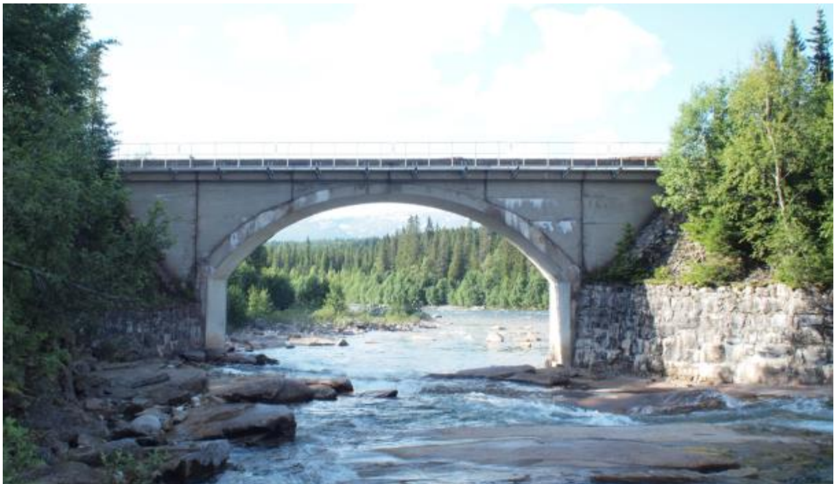
Jernbanebru på Nordlandsbanen ved samløp med Ranaelva.
