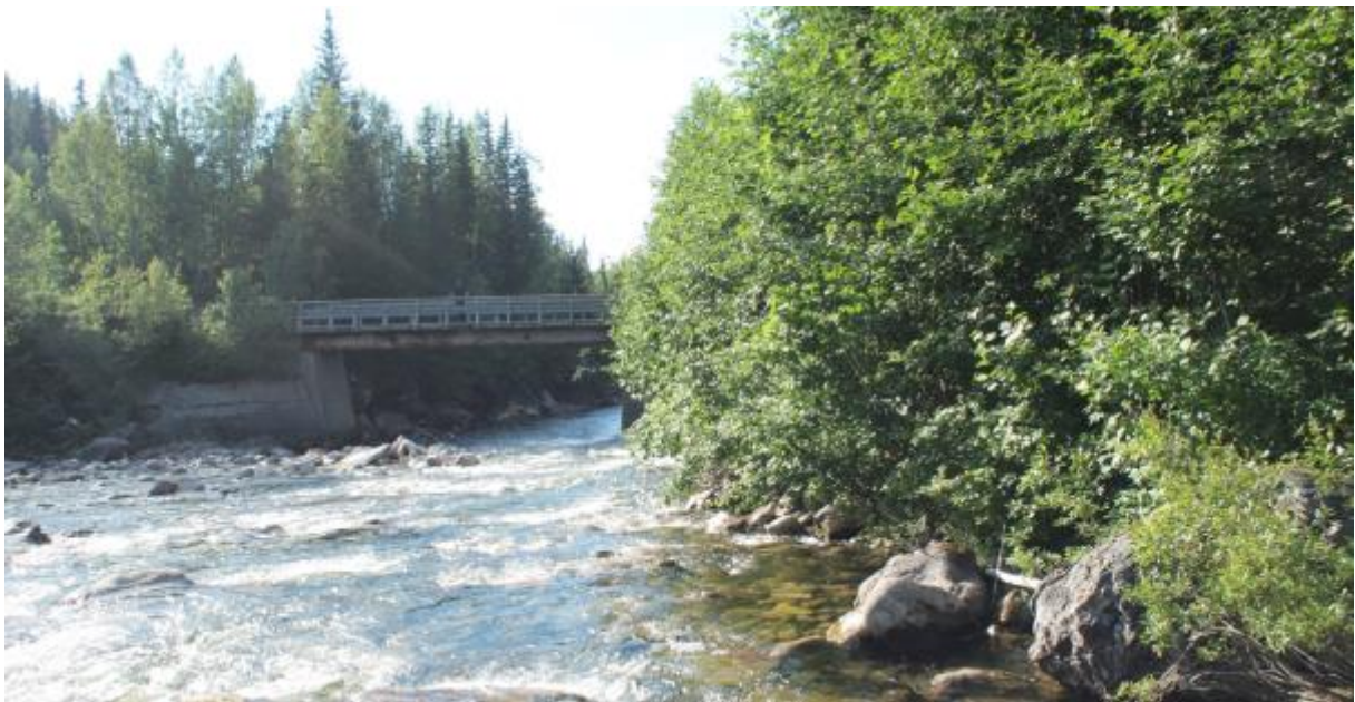
Stupforsmobrua. Nedstrøms utløpskanal.
