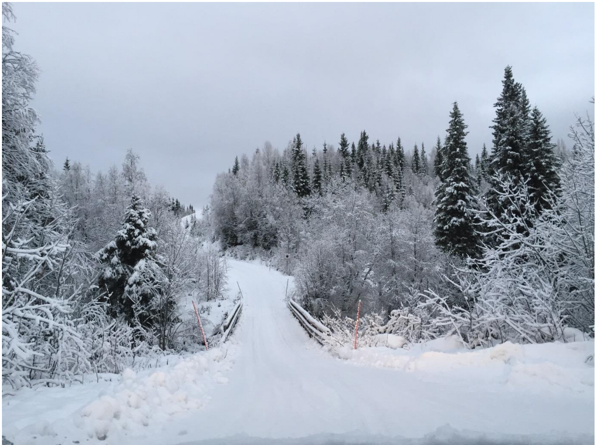
Stupformoveien bru. Kabeltrase langs vei
