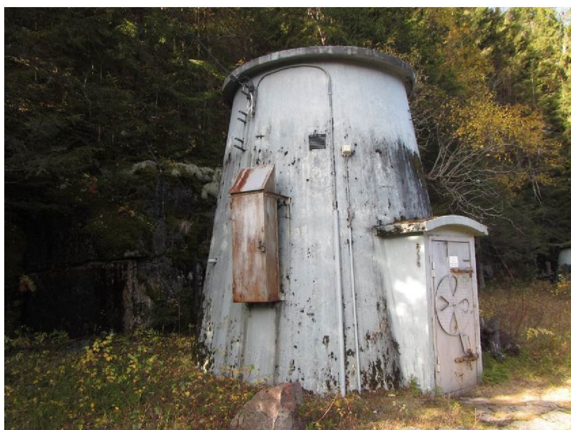
Bilde 3: Lukehus til omløpstunnelen
