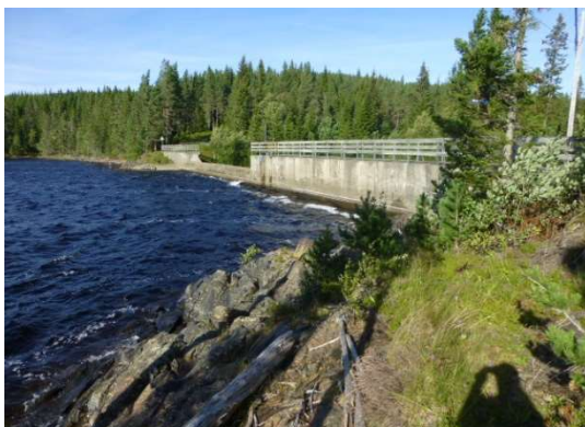
Figur 20 Foldsjødammen sett fra inntaket
