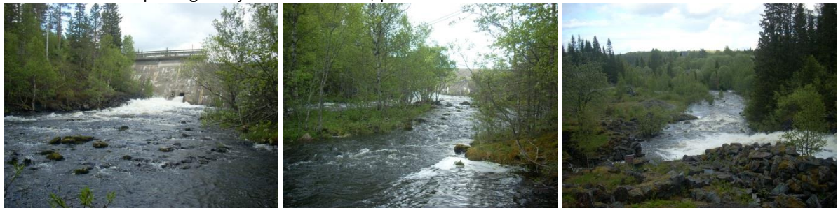
Over sees øvre del av strekningen i Homla som får fraført vann, fra dam Foldsjøen ned mot jernverket.
