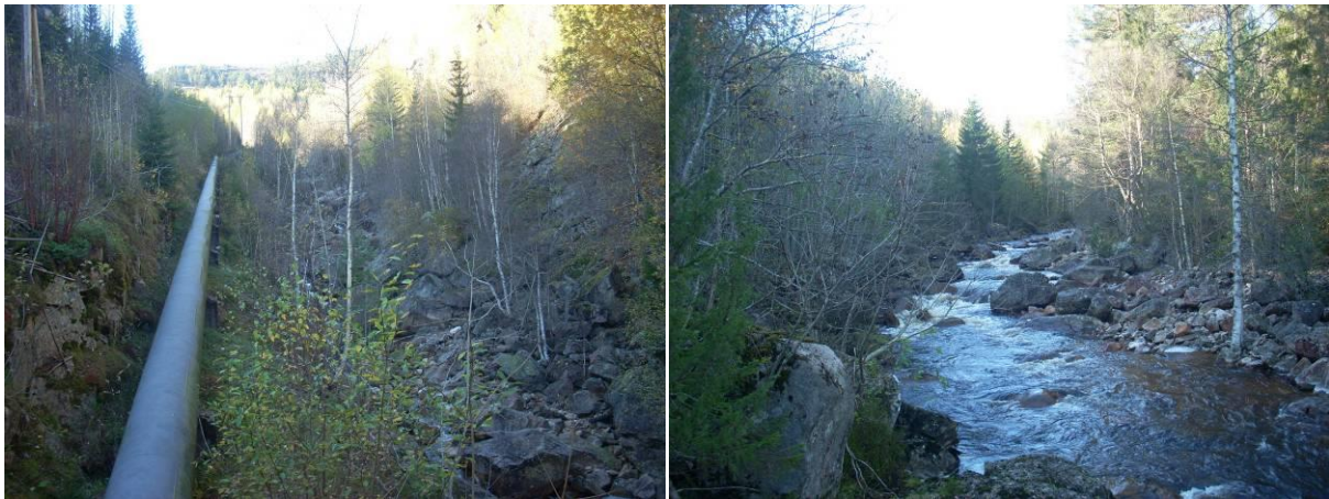
Figur 7: Rørgate i dagen ned mot Suvdøla kraftverk (venstre) og ungskog langs midtre del av ny strekning som planlegges fraført vann (høyre). Fotos: Ole Roer.
