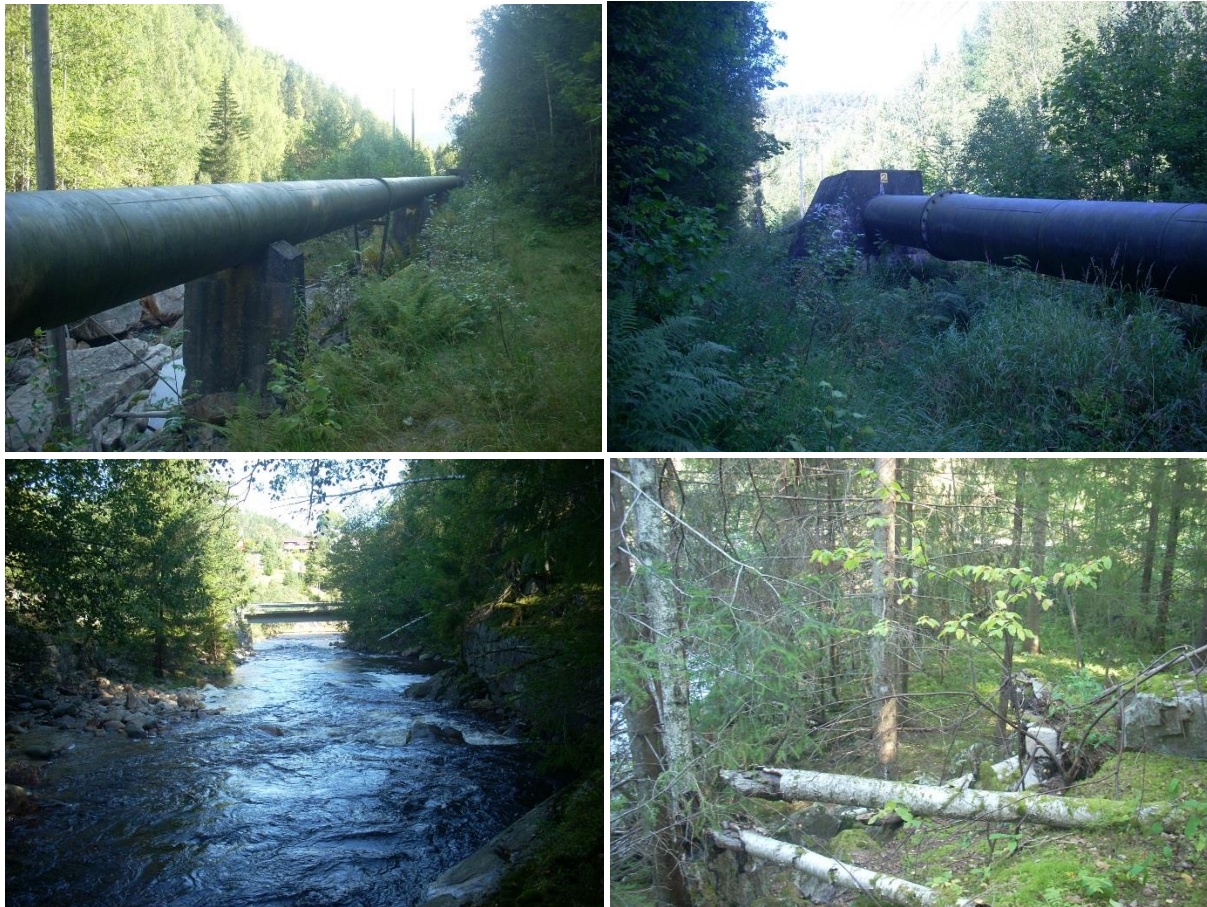
Figur 2: Øvre bilder viser sted for planlagte påkobling til gammel rør rundt kote 190. Bildene under viser planlagt stasjonstomt med utløp nær bro der FV38 krysser elva. Fotos: Ole Roer.
