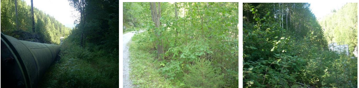
Bildene over viser utgang ny rørgate inkl. parti langs øvre del av ny vannvei.
