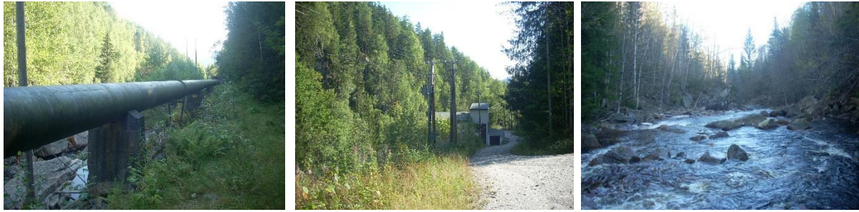
Bildene over viser sted for påkobling til gammel rørgate, Suvdøla kraftverk, samt øvre del av ny utbyggingsstrekning i Suvdøla.
