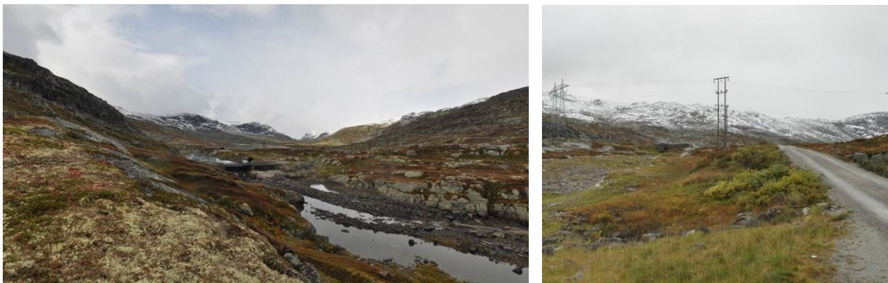
Figur 9-1. Eksisterende dam på venstre bilde ligger skjernet til mellom fjellvegg og kam. Til høyre sees brua som binder dammens adkomst til Rallarvegen med sanert jernbanetrasé under.
