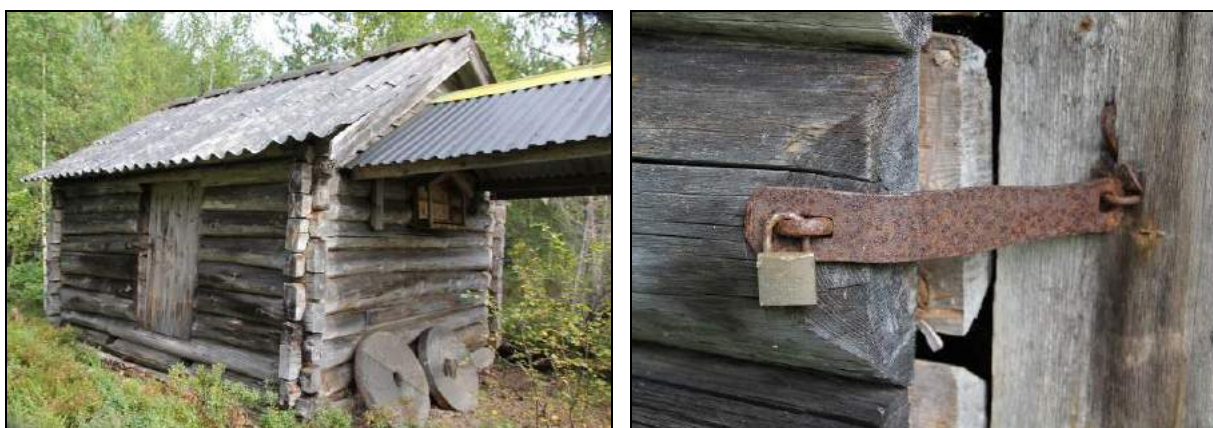
Figur 20. Gammelt kvernhus som har blitt flyttet og satt opp igjen i nedre del av Soks, ca. kote 285.
