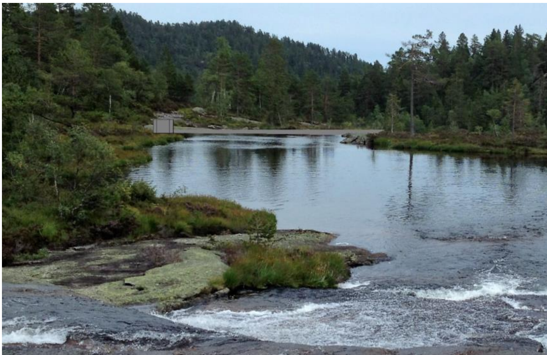
Inntak Steinsvassåne i nederste del av Løkjene tegnet inn. Lavtbyggende dam med inntak som sees til venstre.
