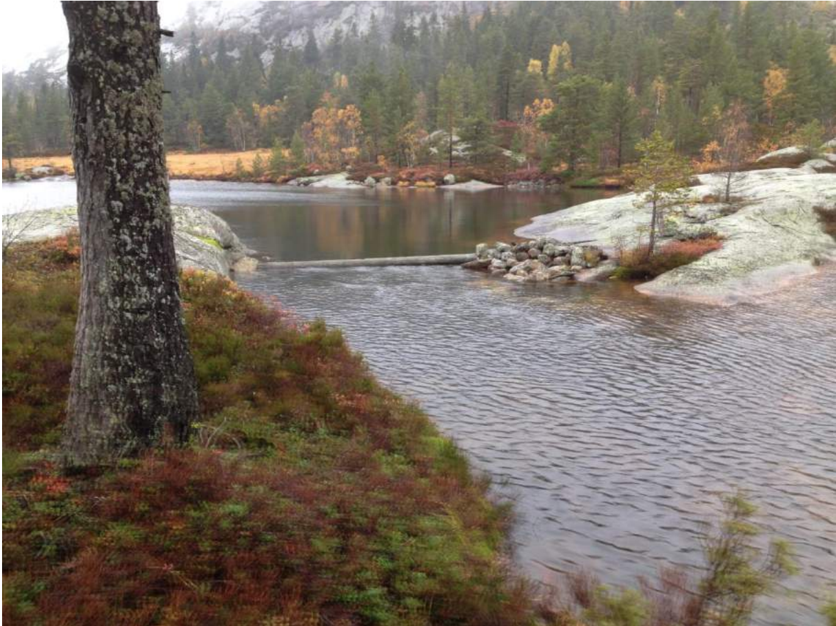
Fig 29. Tømmerdam i utløpet av Steinsvatn.
