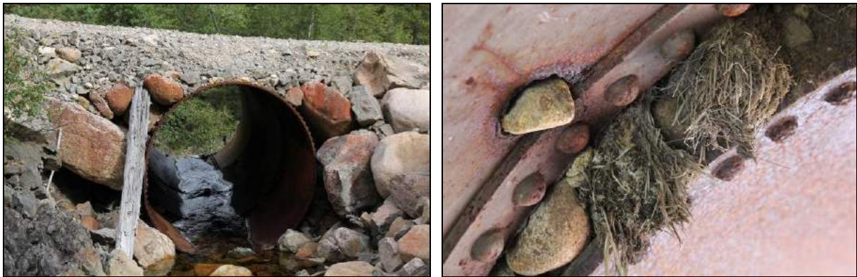
Figur 12. Hekkeglass for fossekall i stålrør under vei, ca. kote 294 i den regulerte elva Soks.
