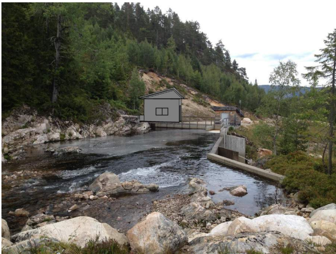
Fig 17. Inntak til Soks kraftverk, Steinsvassåne kraftverk tegnet inn.
