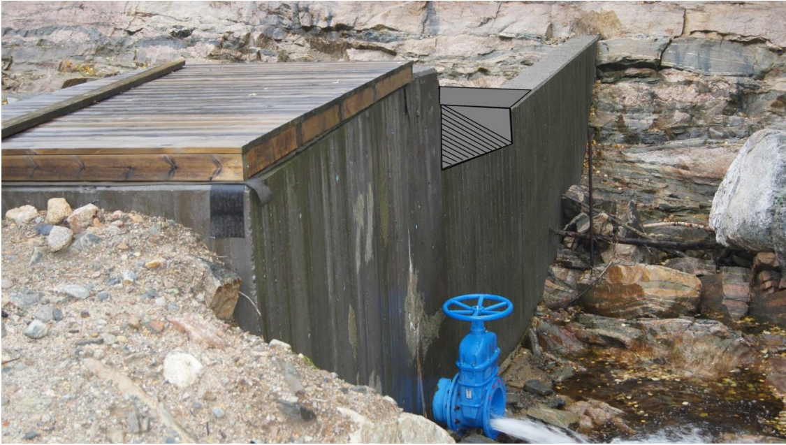
Eksisterende Bekkeinntak Soks Kraftverk.
