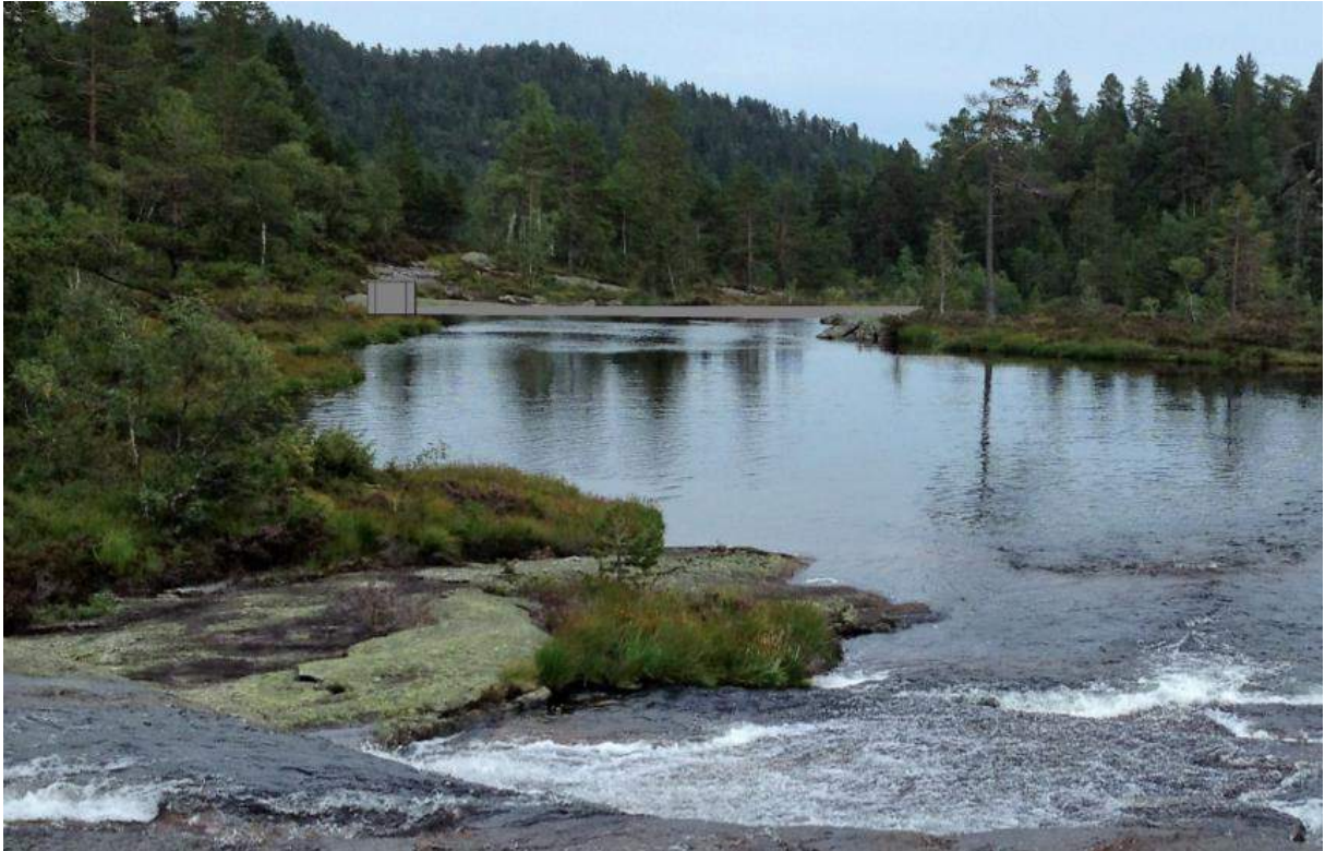
Fig 18. Inntak nederste del av Løkjene tegnet inn. Lavtbyggende dam med inntak som sees til venstre.
