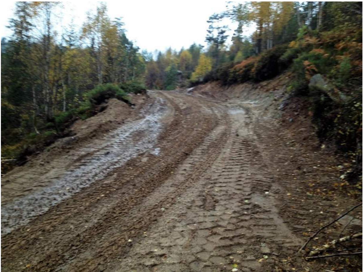
Fig 19. Traktor vei til Løkjene, brukes til nedgraving av rør.
