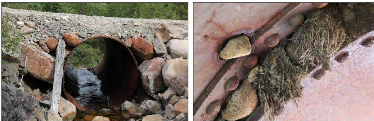
Fig 53. Hekkeplass for fossekall i stålrør under vei, ca. kote 294 i den regulerte elva Soks.
