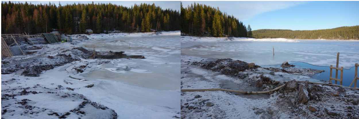
Figur 1 og 2: Bildene er tatt oppstrøms dam. Fangdam og tapperør er etablert med vannstand på 367,8.
