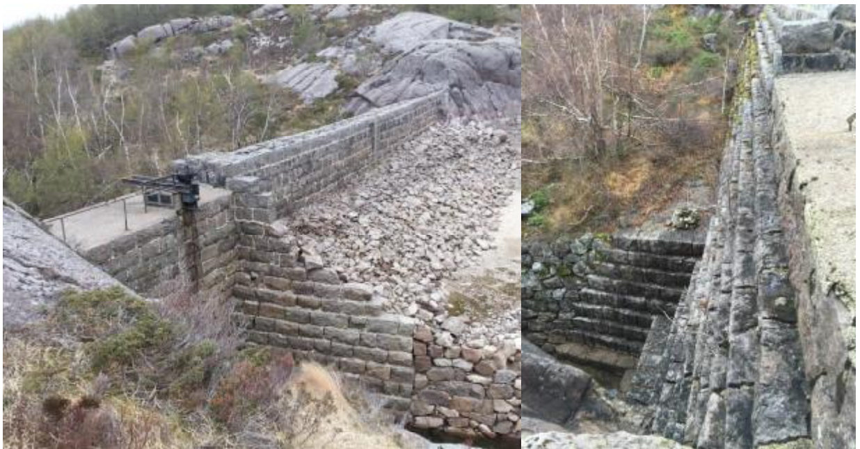
Bildene viser dam Homsevatn fra oppstrøms og nedstrøms side.
