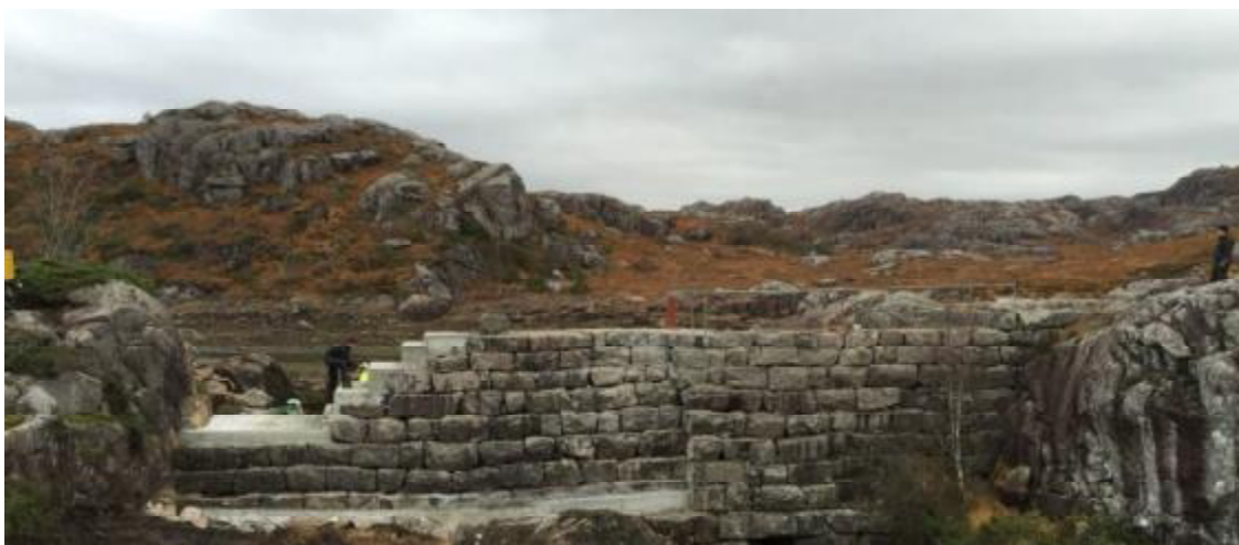
Bilde viser dam Hundsvatn (nedstrøms) etter senkning av overløpet ned til nivå 2 m under opprinnelig HRV. Erfaring fra Hundsvatn viser at denne typen tiltak kan gjennomføres svært skånsomt uten store nye inngrep.
