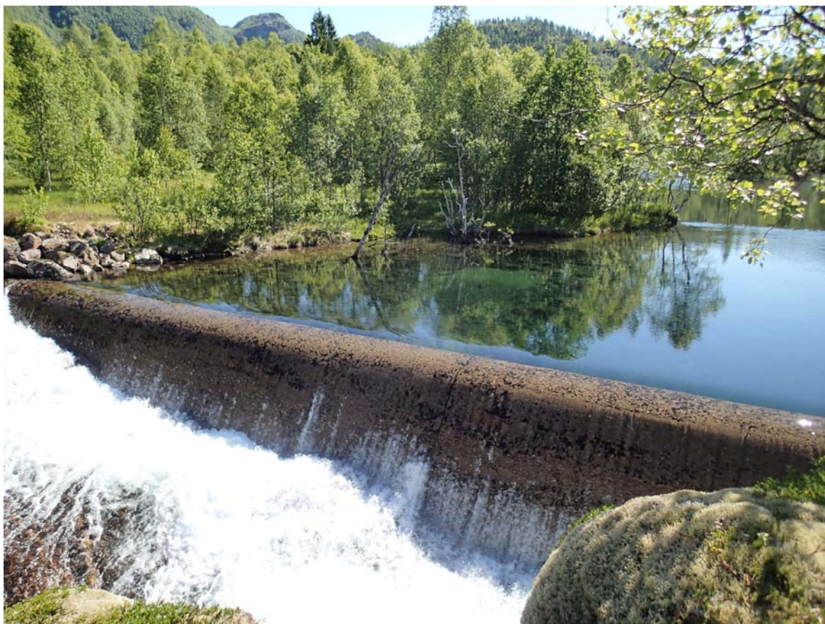
Figur 9 Eksisterende dam i Sørfjordelva kote 50
