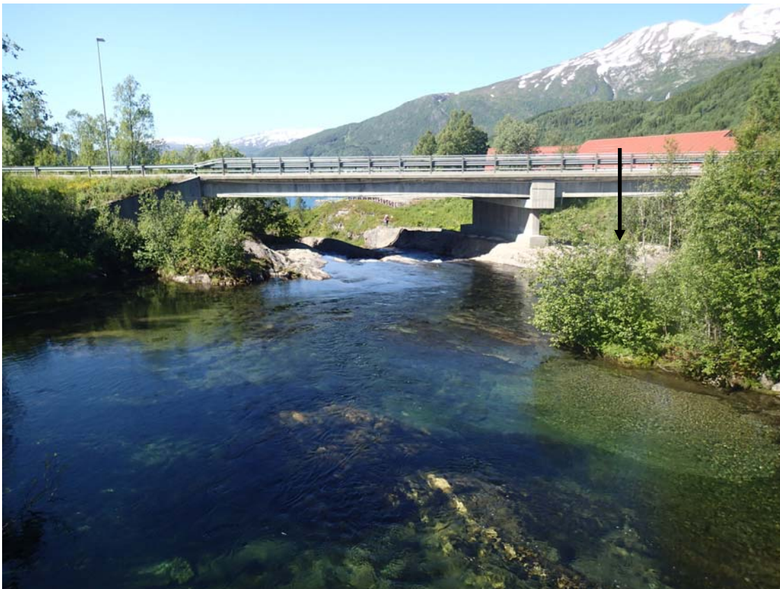
Figur 15 E6 bru over Sørfjordelva. Planlagt inntak minikraftverk kote 26 anvist med pil.
