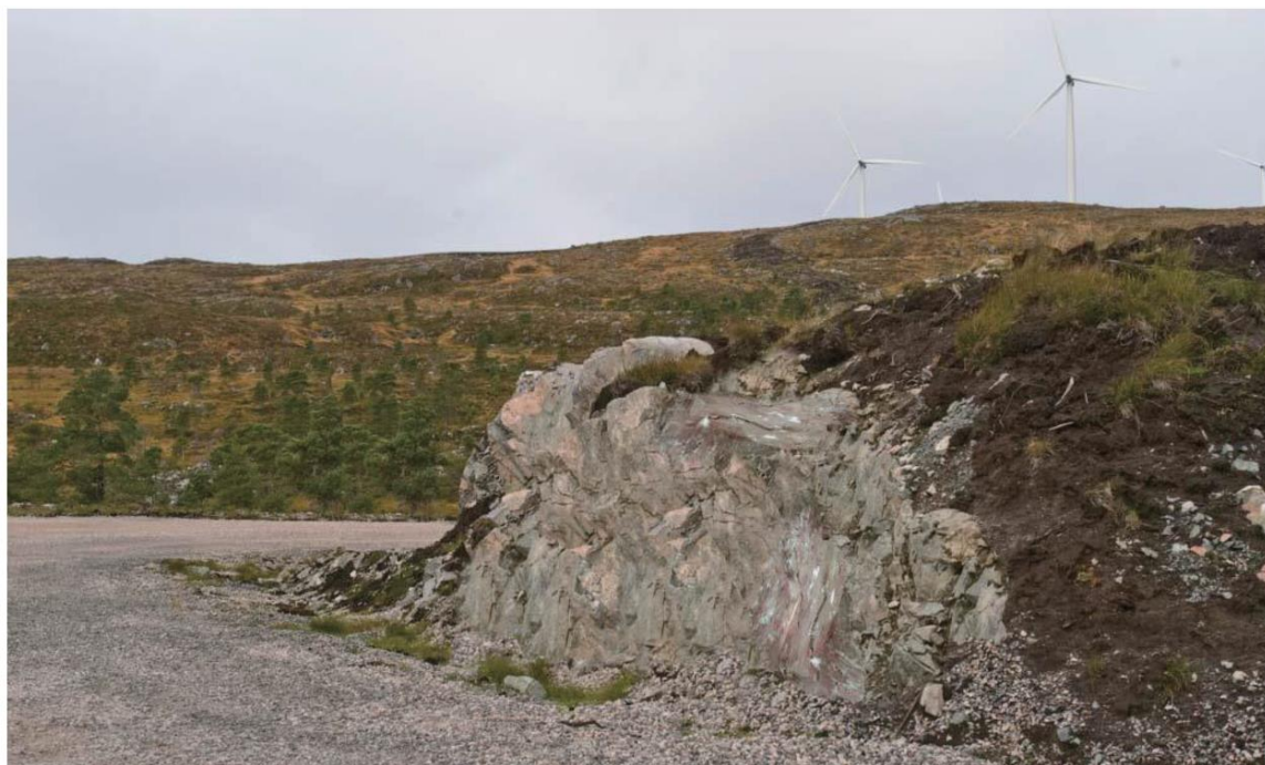
Figur 8 - Fjellskjæring uten tiltak (kilde: Norconsult)
