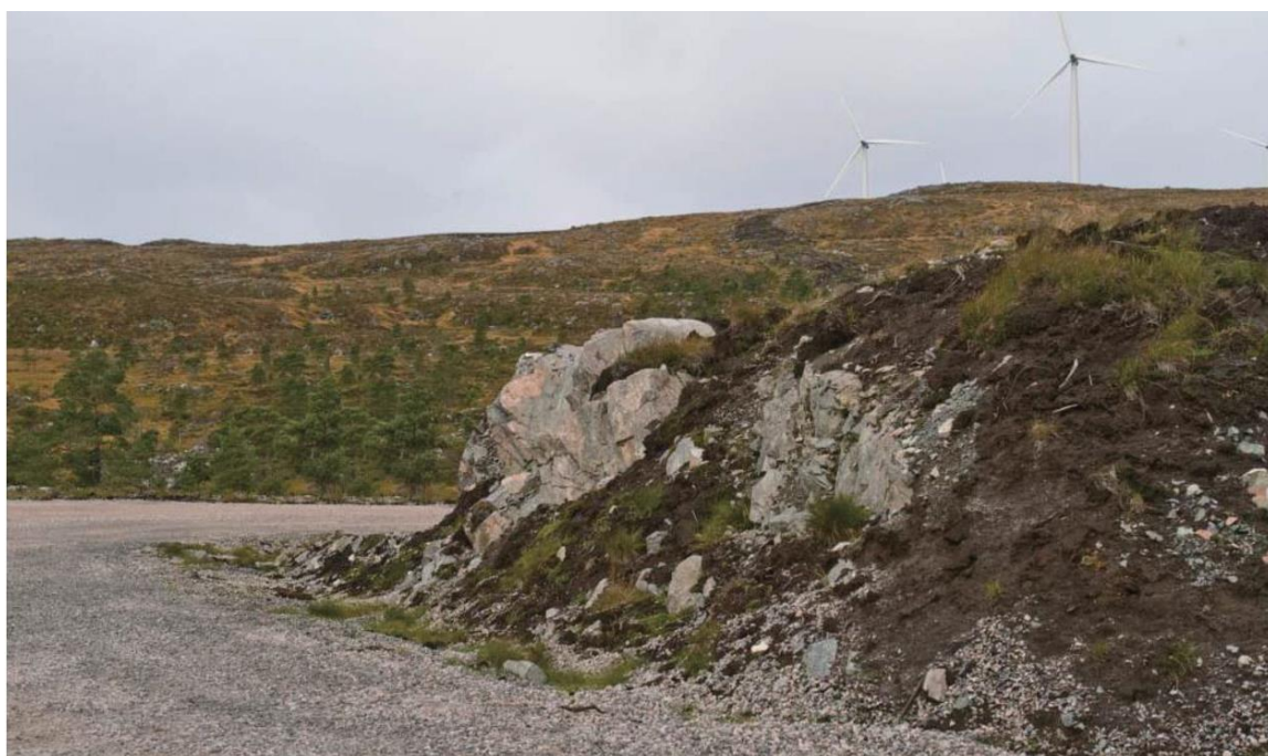
Figur 9 - Fjellskjæring kledd med løsmasser (kilde: Norconsult)
