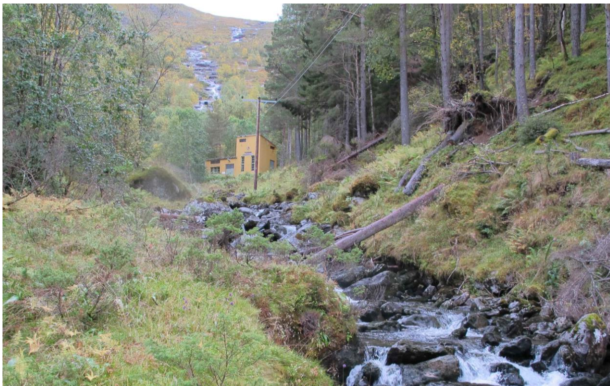
Figur 13. Biletet viser den allereie eksisterande kraftstasjonen i Risaskarelva og høgspenlina som går opp til denne. Ein ser også tydelig at elva er svært bratt og renn over nakne berg og sva ovanfor kraftstasjonen. Som ein ser består botnsubstratet i elva nedom kraftstasjonen av mykje stor stein og blokk (Foto; Oddvar Olsen 28.09.2012 ©).
