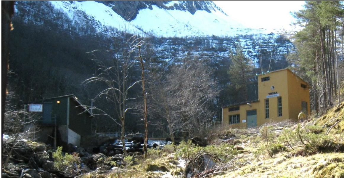
Figur 3 Til høyre ses kraftstasjonsbygningen. Til venstre ses inntaket til vannverket.
