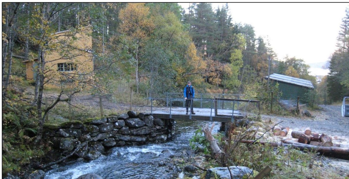
Figur 14 Ny kraftstasjon bygges på samme sted som eksisterende kraftstasjon til venstre.
