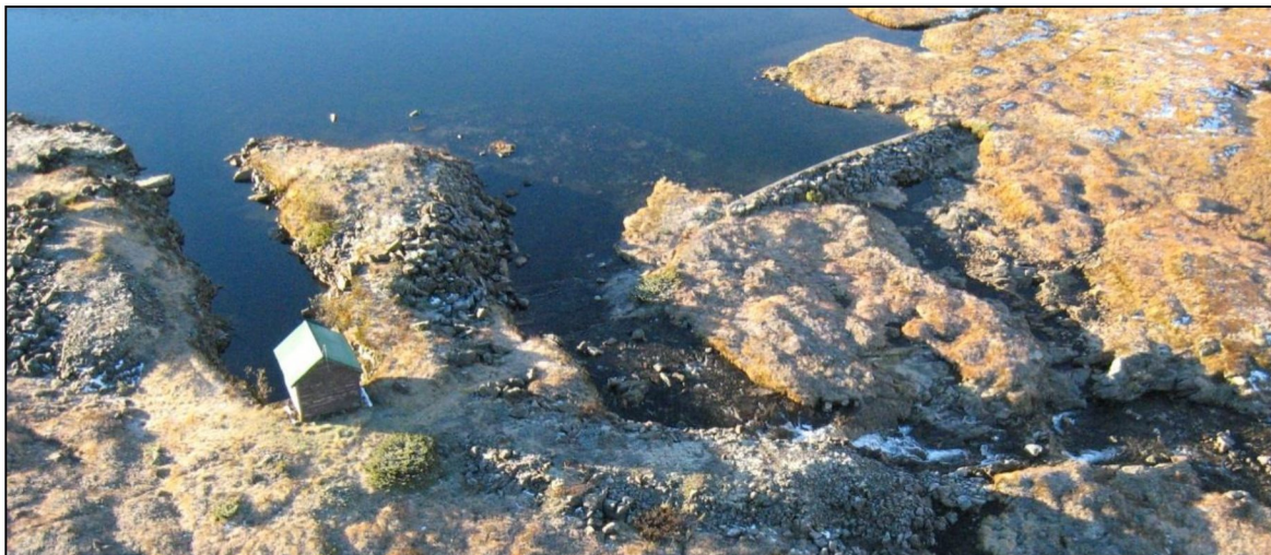
Figur 5 Dam Risaskarvatn med lukehuset til venstre, flomløp i midten og dammen til høyre.
