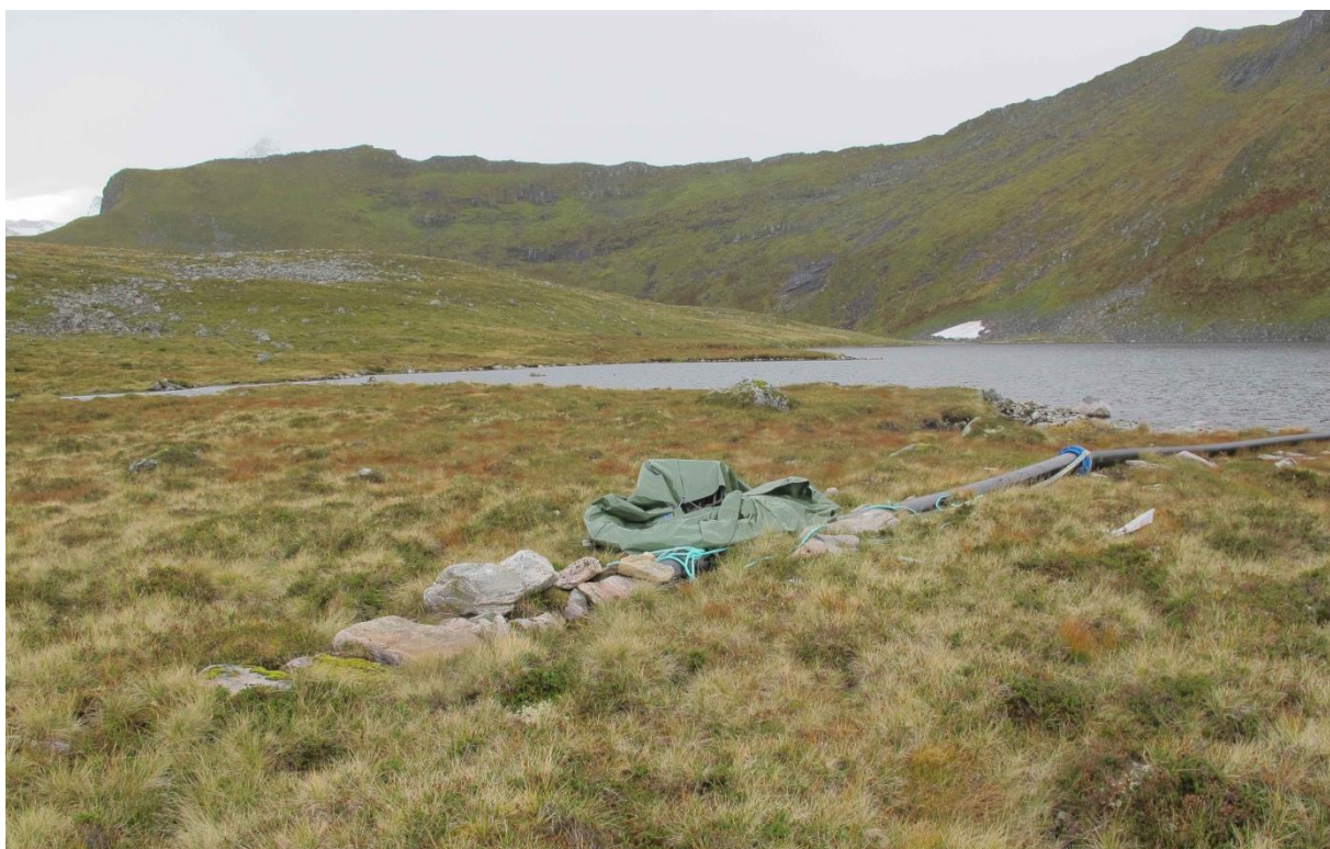
Figur 17 Biletet viser området ved det fremste av Svartevatna. Her ser ein vegetasjonen i området, samt vassleidningen som er lagt frå det fremste av desse vatna og ned i Store Risaskarvatnet for å sikre vassstilførselen til vassverket i turre periodar (Foto; Oddvar Olsen © 28.09.2012).
