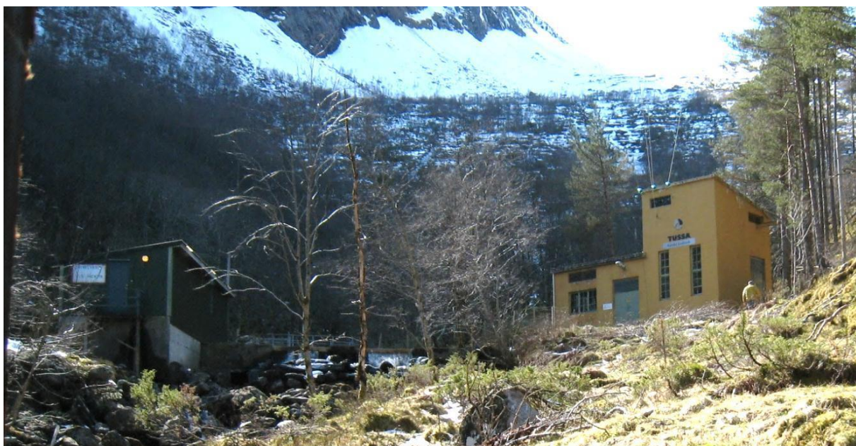
Figur 2: Vartdal kraftverk til høyre, og inntaket til Vartdal vannverk til venstre.
