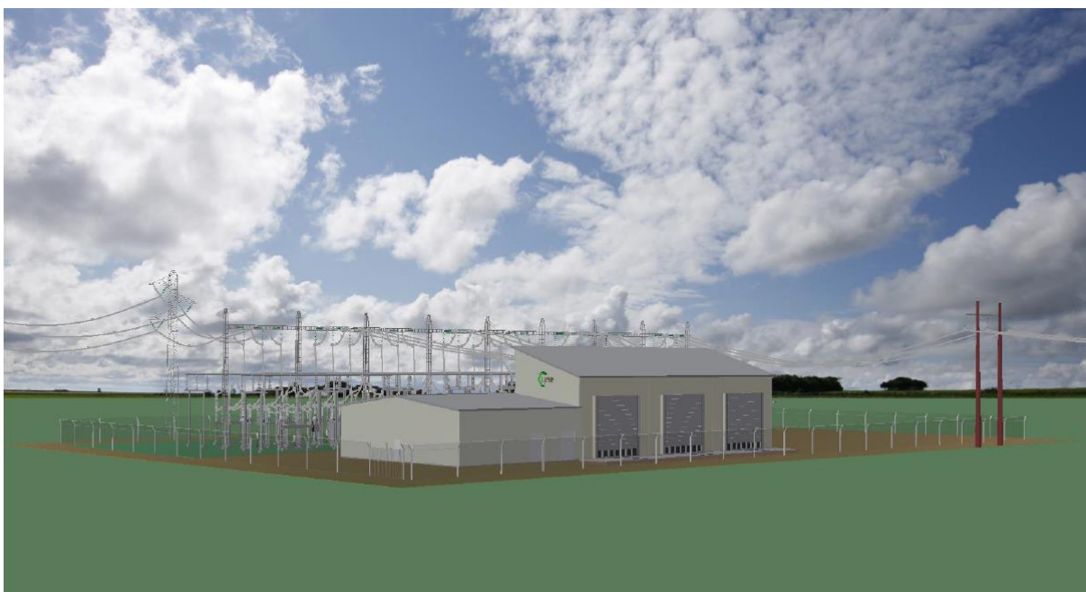
Figur 4.2. Prinsippsskisse av utendørs, luftisolert (AIS) transformatorstasjon
