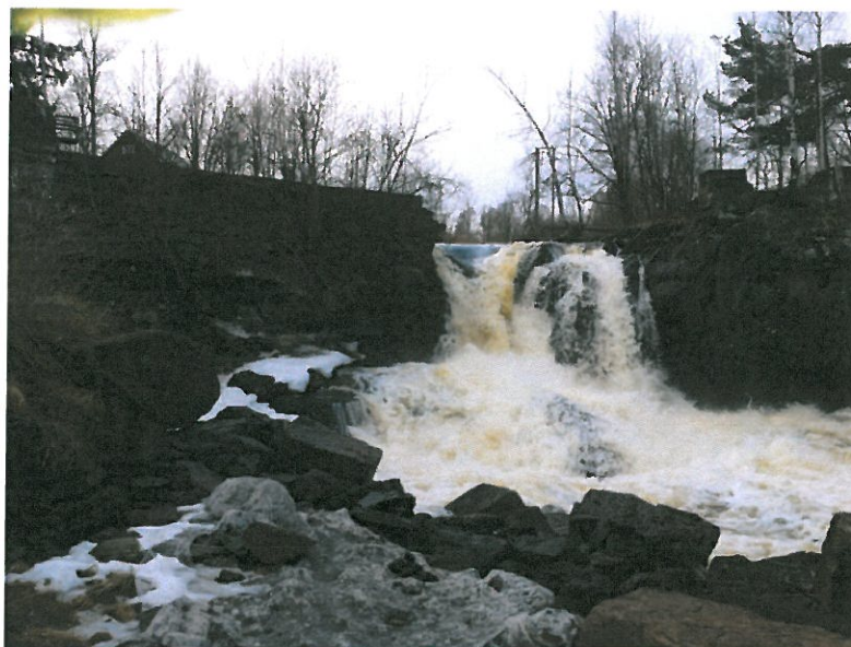
Figur 2 - Løkkadammen sett fra nedstrøms side)
