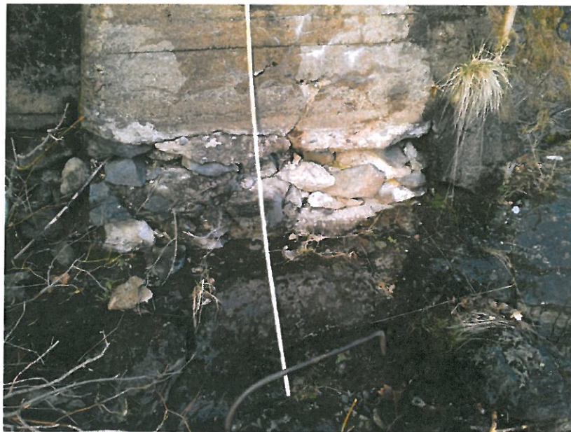
Figur 5 - Løkkadammen. Fot kanalvange ved overløp.
