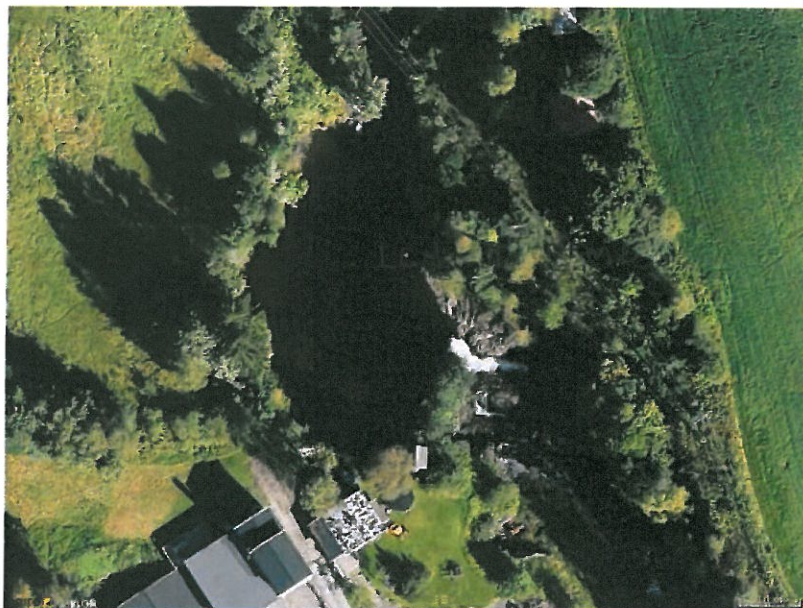
Figur 1 - Oversikt Dam Løkkafossen
