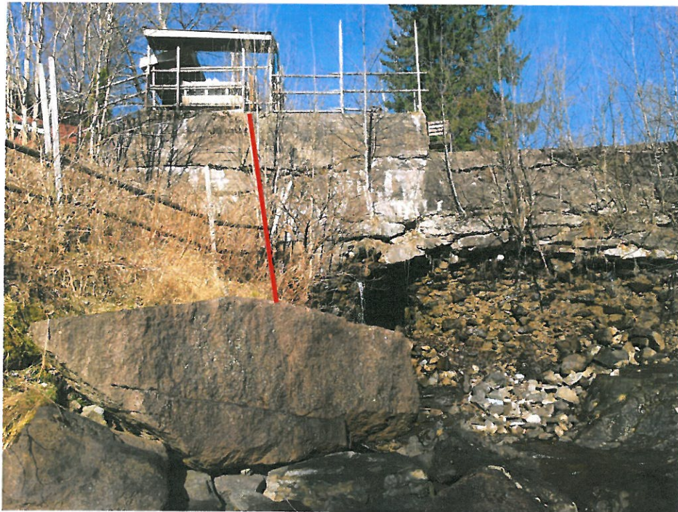
Figur 8 - Løkkadammen. Forslag skjæresnitt Inntaksboks-Dam
