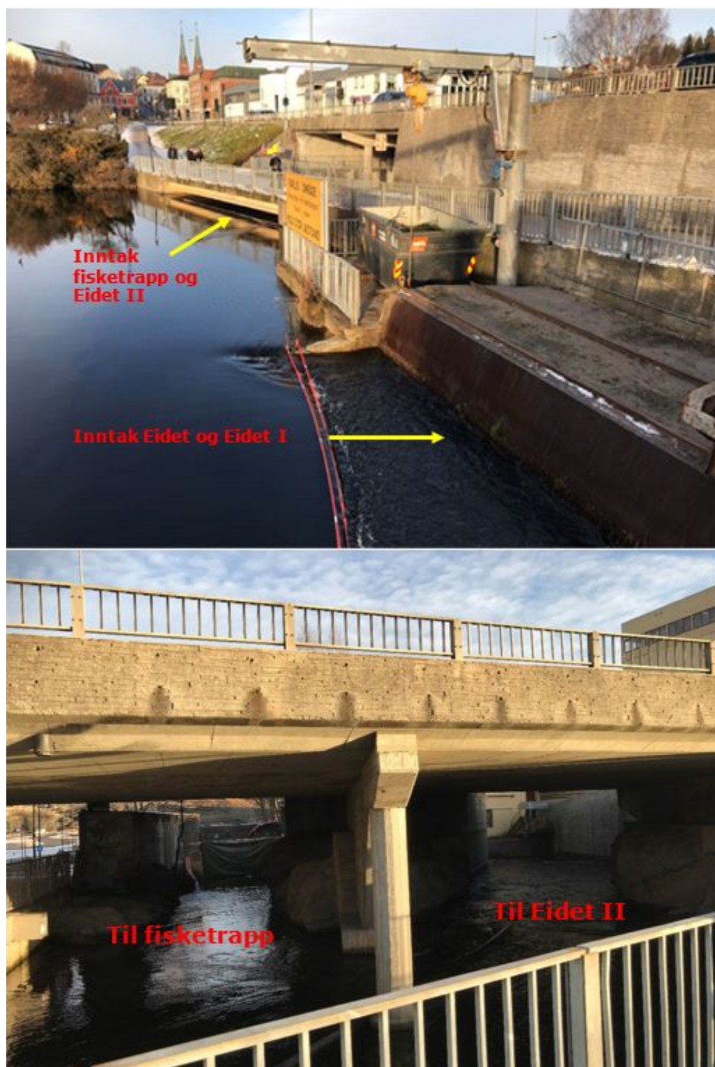
Figur 2-5 Inntakene til fisketrappa og kraftverkene. Det nederste bildet er tatt fra gangveien og viser kanalene inn mot fisketrappa og Eidet II.
