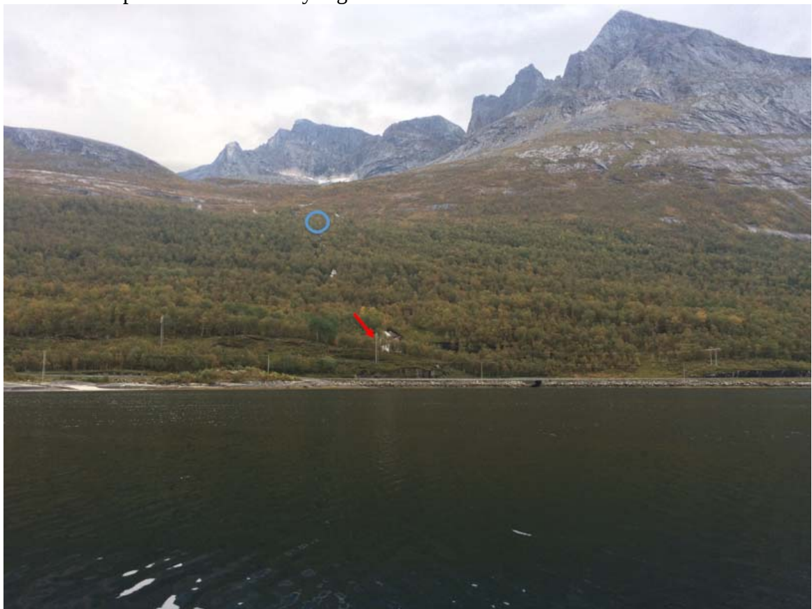
Figur 3-3 Oversiktsbilde av Tindåga og prosjektområdet. Bildet er tatt fra vest mot øst. Blå sirkel viser omtrentlig planlagt inntakssted, og rød pil viser omtrentlig kraftstasjon. Merk at kraftstasjon er planlagt i bakkant av haug mellom FV 17 og elva og vil ikke bli synlig fra fjorden eller vegen. Foss ved kraftstasjon er synlig til høyre for kraftstasjonsområdet.
