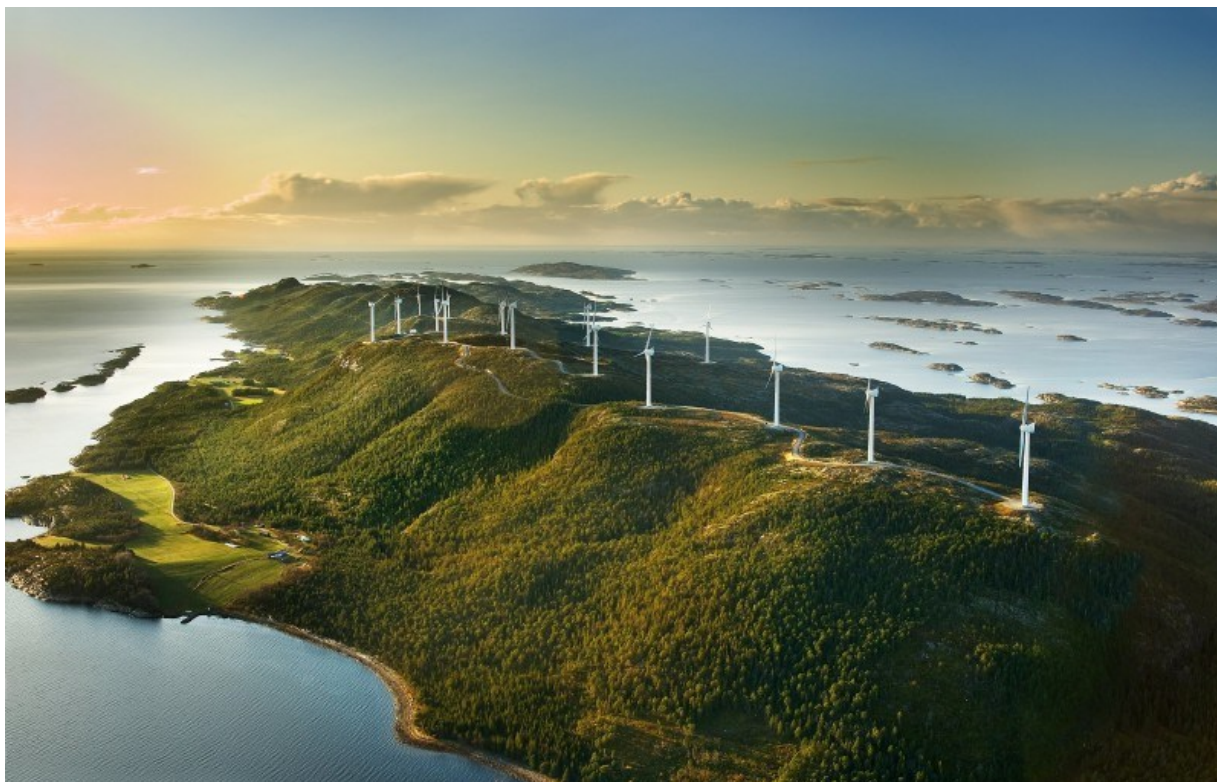
Figur 10. Hundhammerfjellet vindkraftverk etter utbygging (før rivning av enkelte turbiner).
