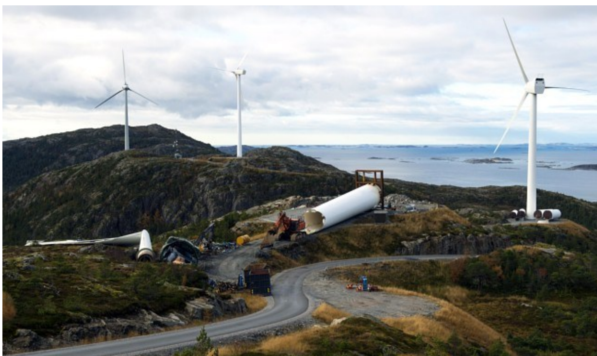
Figur 3. Nedtaking (kontrollert velting) av turbin M4 («Demo 1») på Hundhammerfjellet i 2012.
