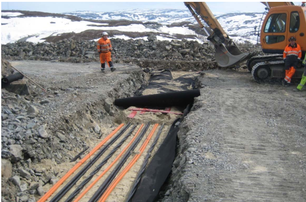
FIGUR 6: BILDE FRA KABELLEGGING PÅ NYGÅRDSFJELLET VINDPARK, NARVIK KOMMUNE
