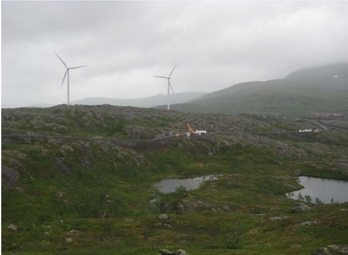
Figur 15: Forholdsvis bratt fyllingskråning med tykkere lag av avdekkingsmasser i foten og skinnere mot toppen
