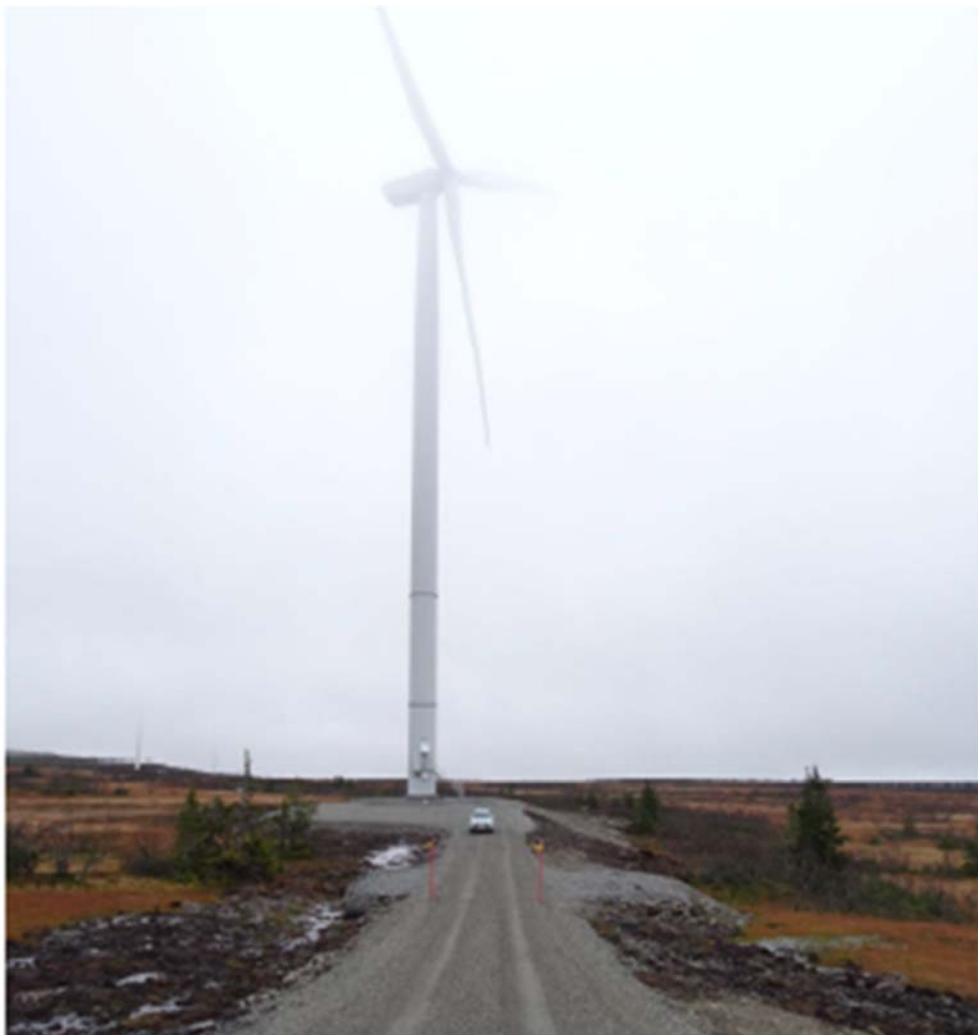
Figur 4: Arronding med toppmasser. Blaiken Storuman kommun i Sverige
