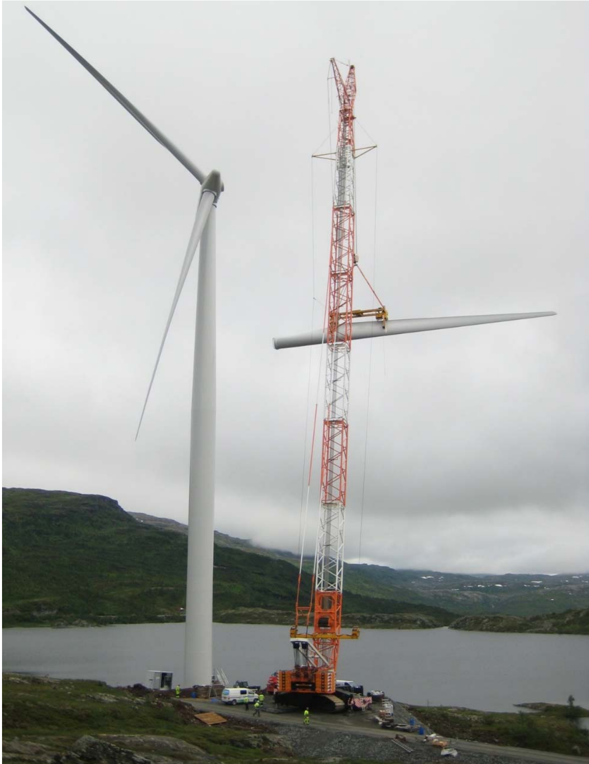
Figur 17: Illustrasjon fra byggingen av Nygårdsfjellet vindpark, Narvik kommune.
