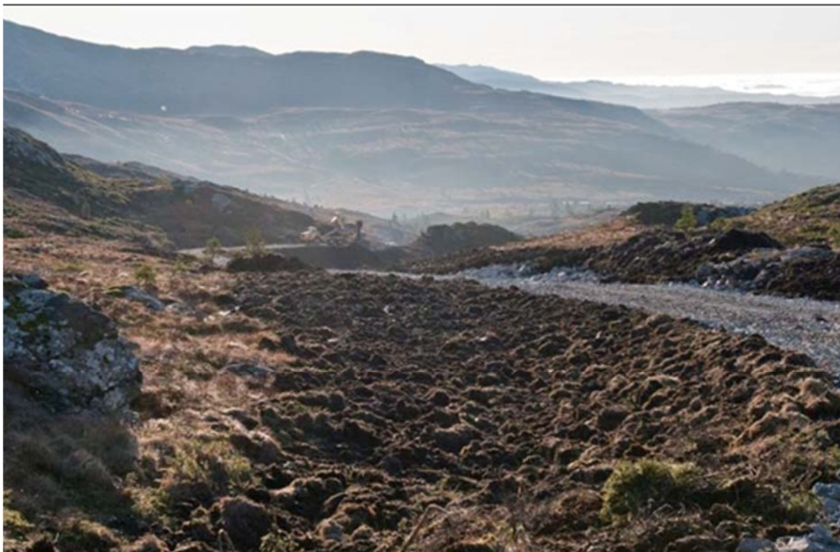
Figur 21: Der det ikke er mulig å få lagt tilbake flak av toppdekket, skal massene legges forsiktig ut på sideterrenget som skal dekkes, uten å klappe til eller kompaktere massene. Det kan kanskje se uryddig ut den første tiden, og på nært hold, men dette vil i lengden gi et mer naturlig resultat. Eksempel fra Midtfjellet vindpark. Foto: Einar Berg
