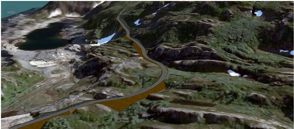
Figur 12: Illustrasjon av vei i terrenget opp mot trafo- og servicebygg på Middagsfjellet, Sørfjord vindkraftverk
