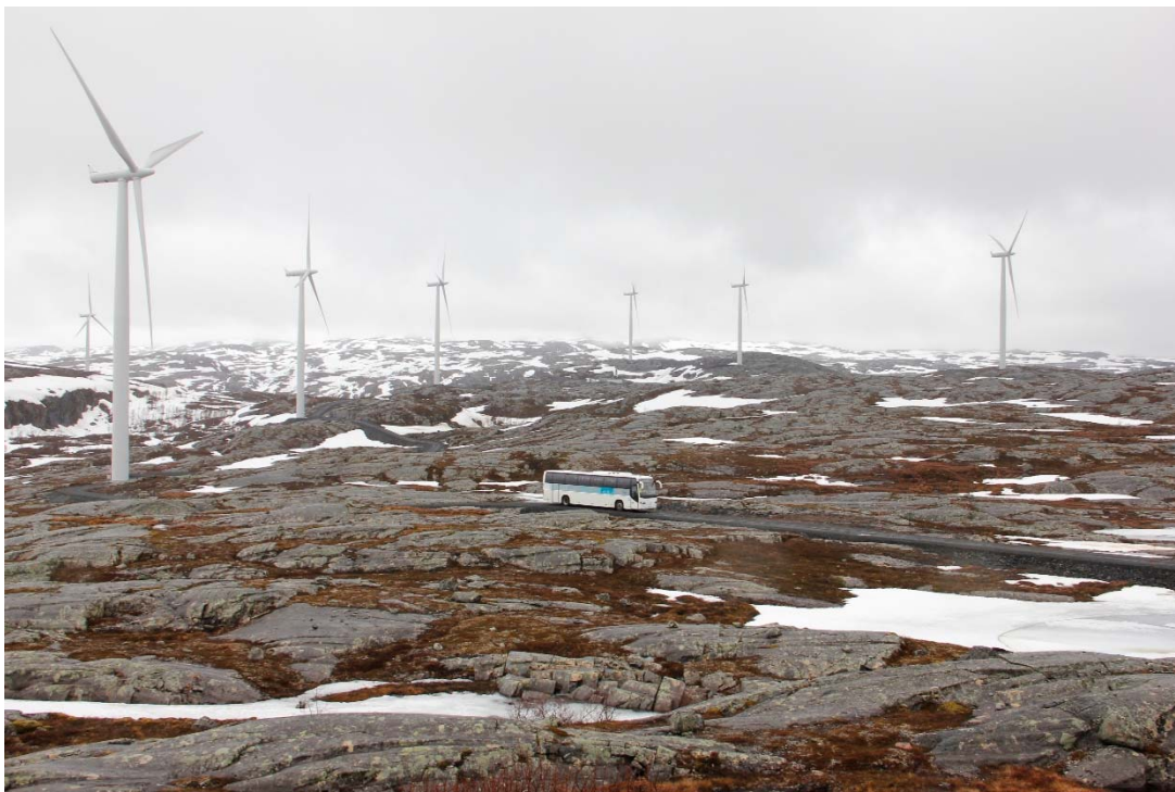
Figur 10: Figur 9 og 10 viser eksempler fra Nygårdstjønn, Narvik kommune hvor veiene ligger godt tilpasset terrenget, her er også fargen på veimassene forholdsvis lik fargen i terrenget rundt noe som demper inntrykket av veiene.
