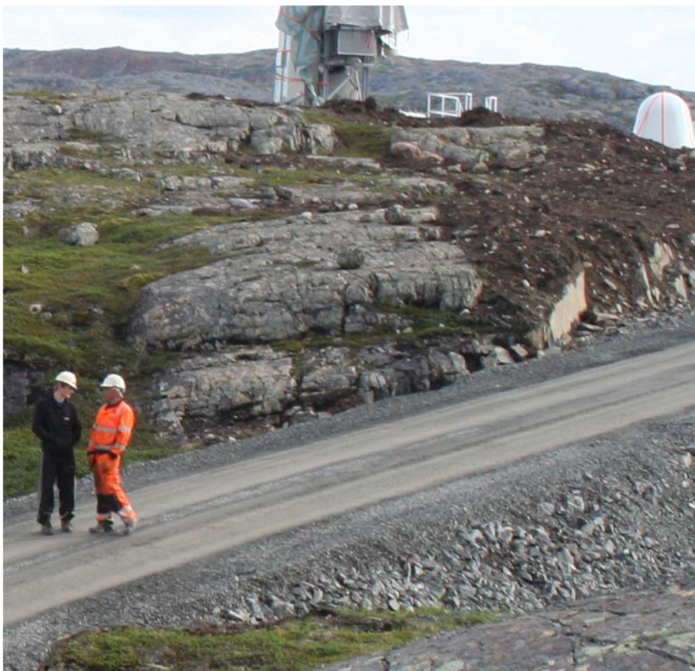
Figur 14: Ved å trekke massene nedover skjæringen og inn i skjæringsfoten vil man få en bedre landskapstilpasning og visuell forankring.
