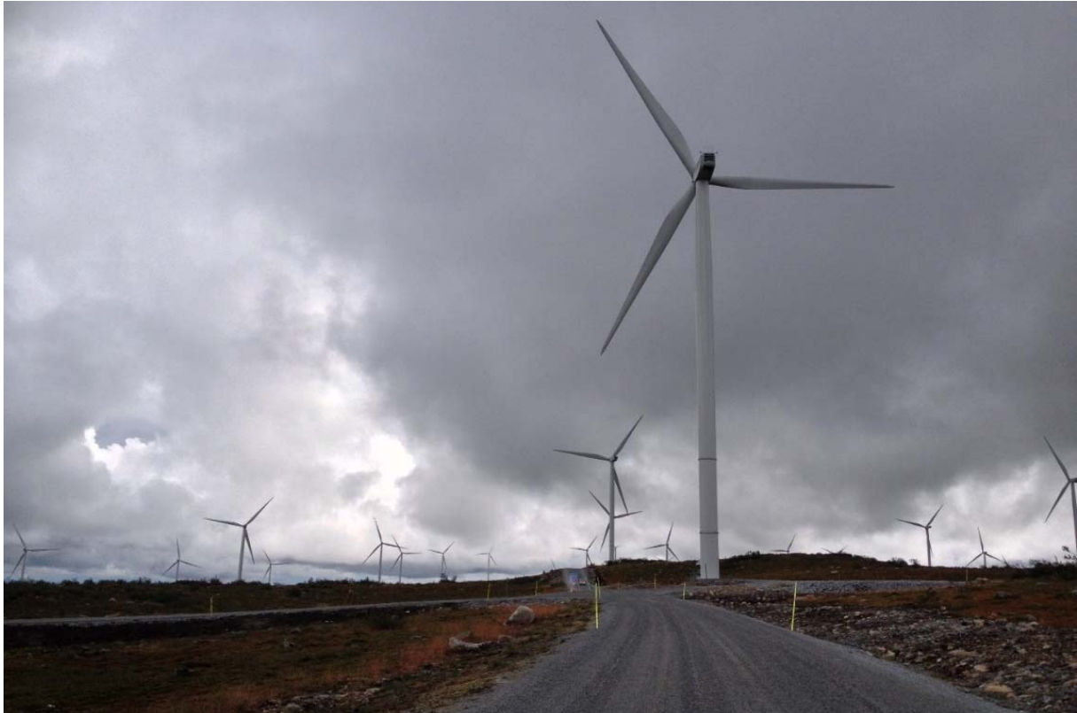
Figur 11: Eksempel fra Blaiken hvor veiene ligger fint i terrenget med gjennomtrengelige voller, uten for høye grøfter
