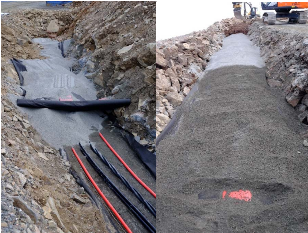
FIGUR 18 : BILDER FRA KABELLEGGING PÅ ÅNSTADBLÅHEIA VINDKRAFTVERK, SORTLAND KOMMUNE
