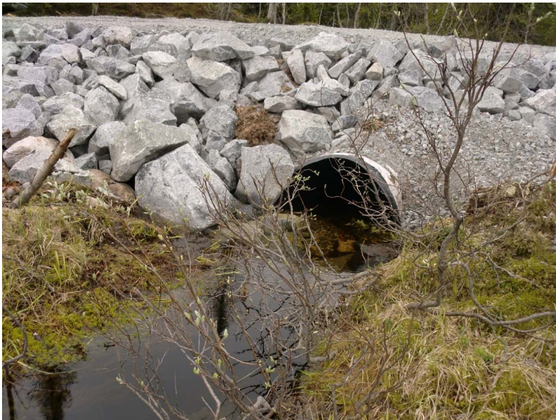
Figur 8: Kulvert utført i henhold til krav om at bunnen skal være nedsenket, 30 cm. Situasjon fra Blaiken.
