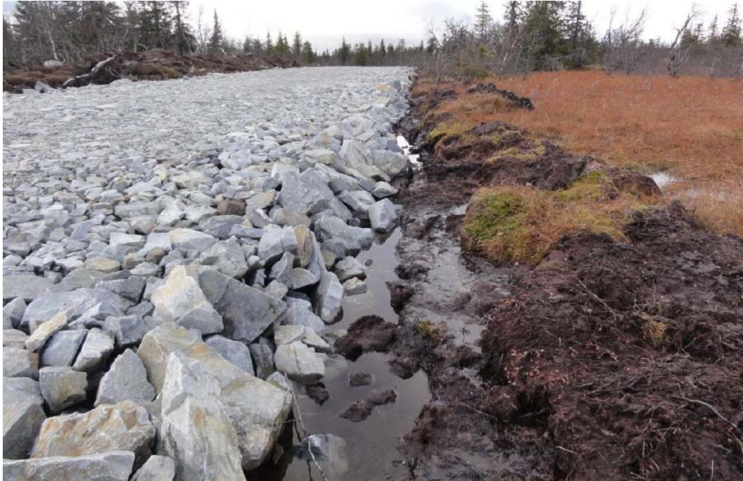
Figur 7: Eksempel på grov veifylling i myrområde fra Blaiken vindkraftverk i Storuman. Foto fra Rambølls kontrollprogram hydrologi for BlaikenVind AB
