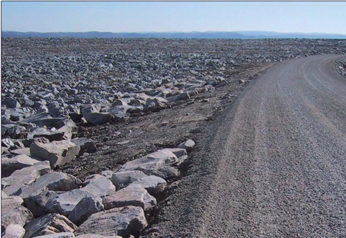
Figur 13: Det vil ikke være nødvendig med grøfter langs veien der det er så godt drenerende masser som her. Overgangen mellom inngrep og eksisterende terreng utføres så mykt som mulig. Stein med fin patinering tas vare på og plasseres tilbake i terrenget med den patinerte siden opp. Fra Kjøllefjord vindpark. Foto: Svein-Rune Wian
