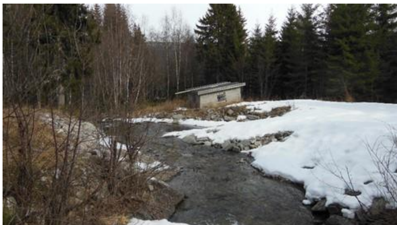
Figur 1-4 Inntaket til anlegget
