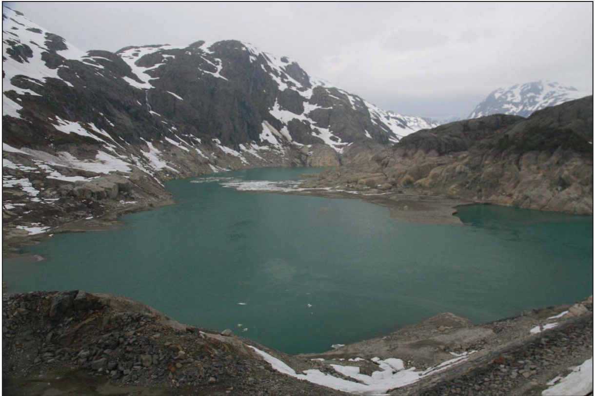
Fig. 2. Som hovedgrunnlag for den store kraftproduksjonen i Blådalsvassdraget er det 3 større magasin i høyfjellet, her Blådalsvatn som har en reguleringshøyde på over 100 meter. 3. juli 2015. Foto: A. Håland.
