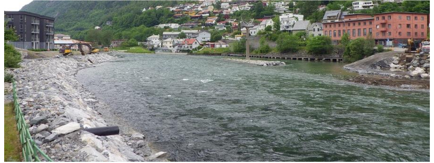
4) Nedre del av Opo med vassføring 74 m 3 /s, 15.6.2017.
