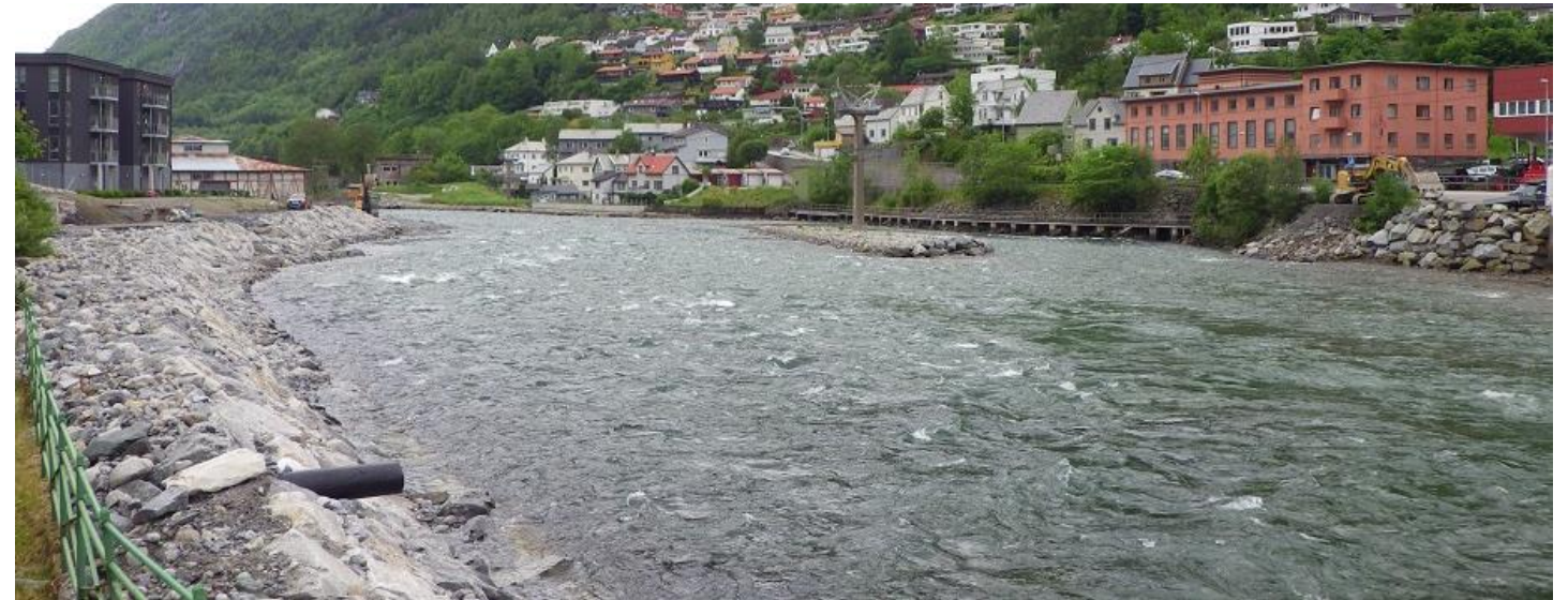
5) Nedre del av Opo med vassføring 106 m 3 /s, 9.6.2017.
