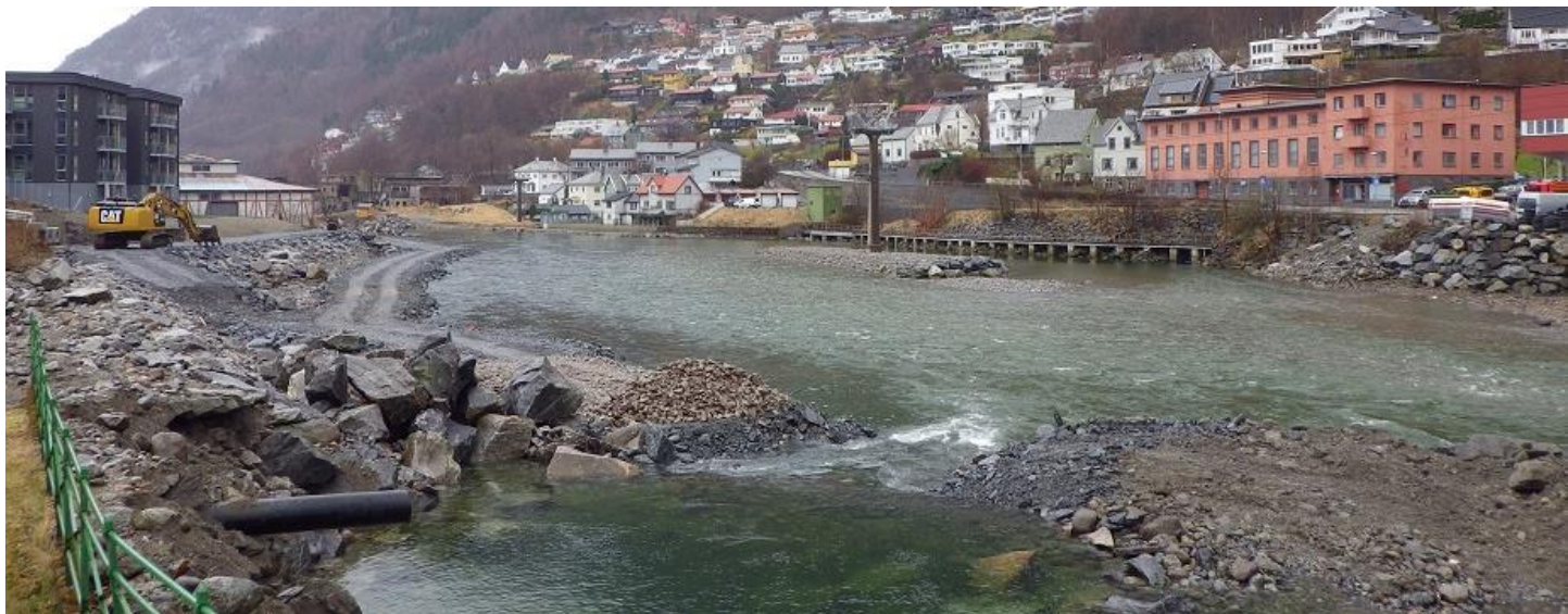
3) Nedre del av Opo med vassføring 28 m 3 /s, 6.4.2017.
