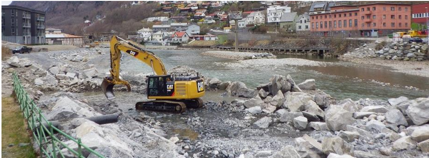
2) Nedre del av Opo med vassføring 9 m 3 /s, 19.4.2017.
