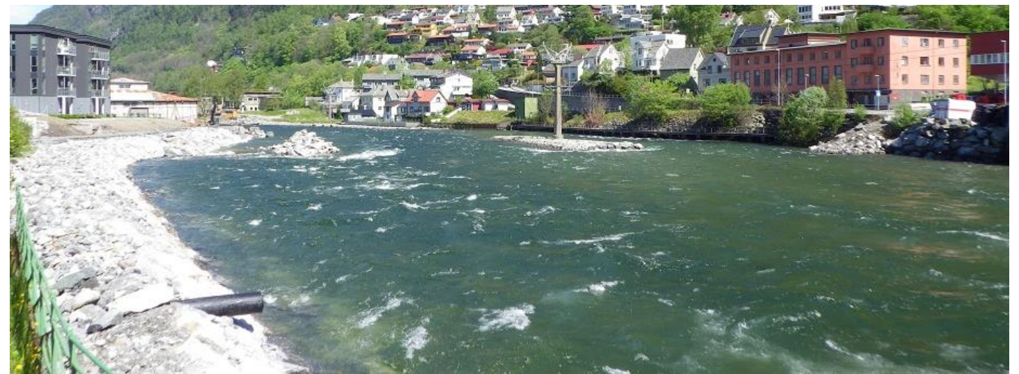
6) Nedre del av Opo med vassføring 185 m 3 /s, 19.5.2017.
