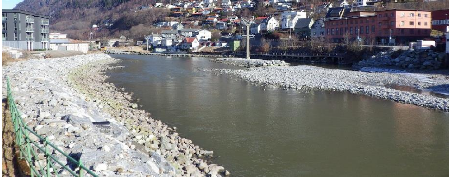
1) Nedre del av Opo med vassføring 4 m 3 /s, 7.3.2017.
