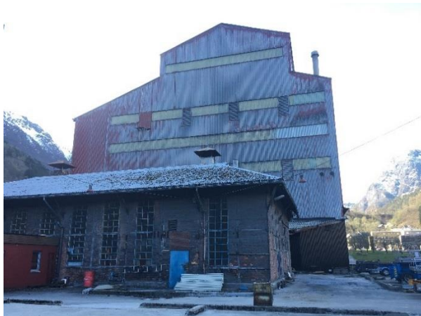
Figur 7-4 Objekt innenfor kulturmiljøet på smelteverkstomta. Taubanen som går mellom smelteverket og kaien på Almerket, en av de eldste produksjonshallene og smelteovnen. Sweco
