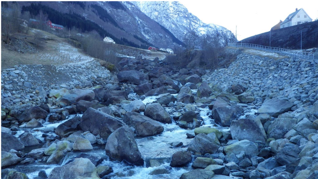
Figur 7-10 Bildet viser nedre del av Eidesfossen 07.03.2017 med vannføring på 4 m 3 /s. Da er det meste av elveleiet eksponert. Midten av elveleiet har en naturlig utforming med stor og løs stein som elven har ført med seg. Breddene er plastret for å hindre erosjon.
