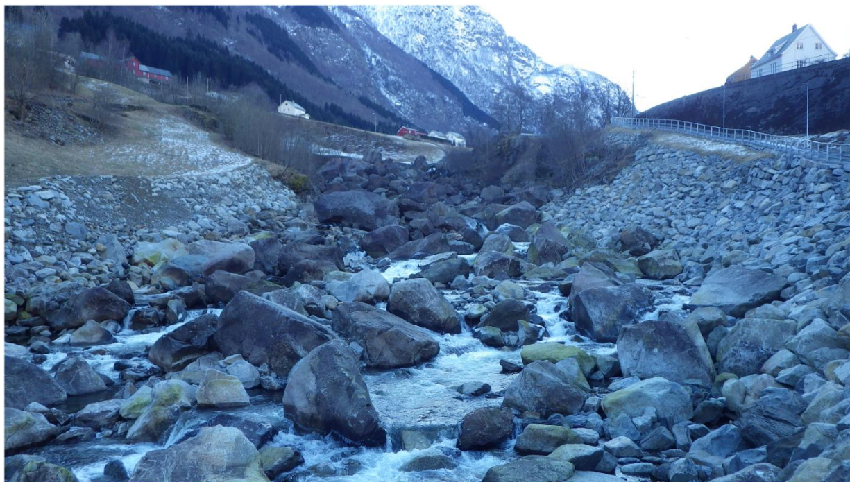
Figur 8-8 Bildet viser nedre del av Eidesfossen 07.03.2017 med vannføring 4 m 3 /s
