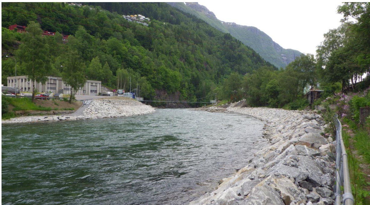
Figur 7-16 Bildet viser Opo nedenfor Hjadlakteivane 15.06.2017 med vannføring på 77 m 3 /s. Inntrykket er helt klart en fullere elv, men strekningen er mindre sårbar for endringer i vannstand enn de mer kupertene strekningene lenger opp i elven.
