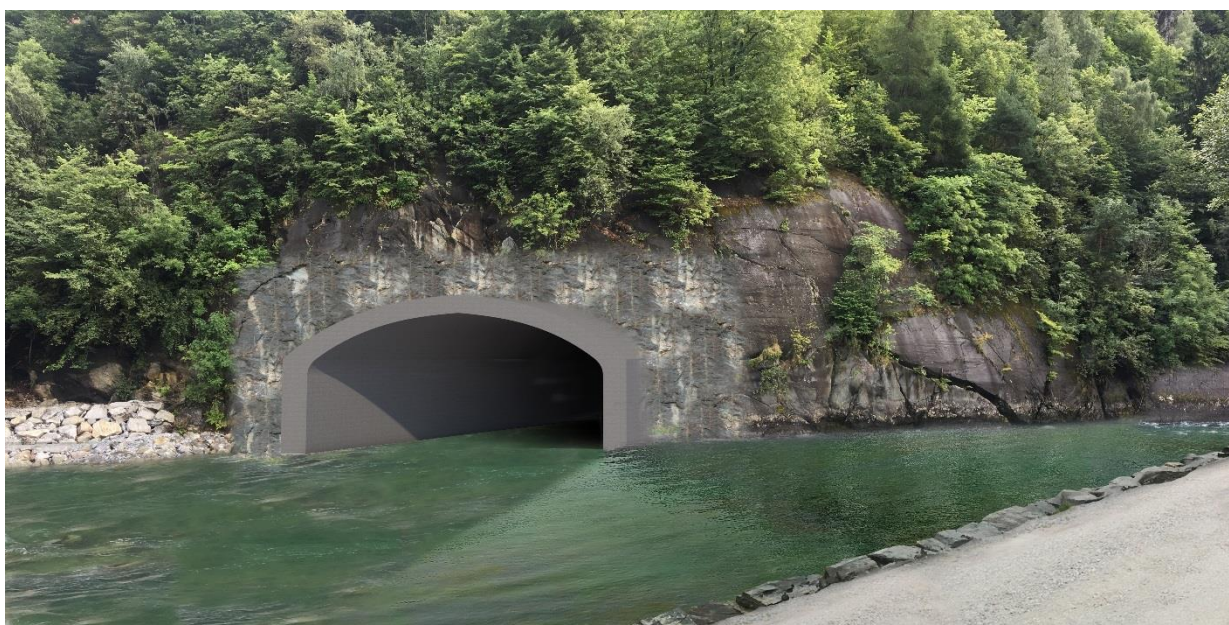
Figur 8-22 Illustrasjonen viser utløpet av flomtunnelen ved Hjadlakteivane.
