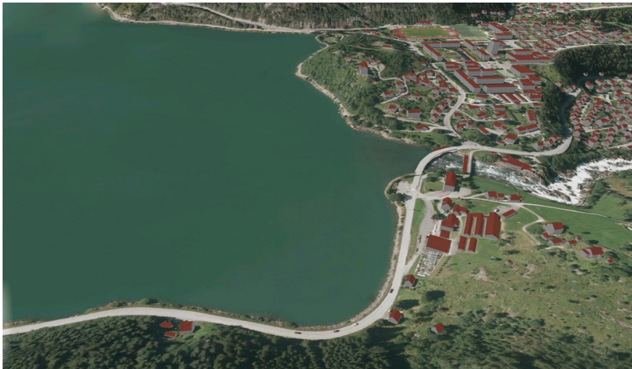
Figur 8-19 Illustrasjonen viser deponi Vasstun. Alternativ øst vil ikke deponere masser ved Odda camping.
