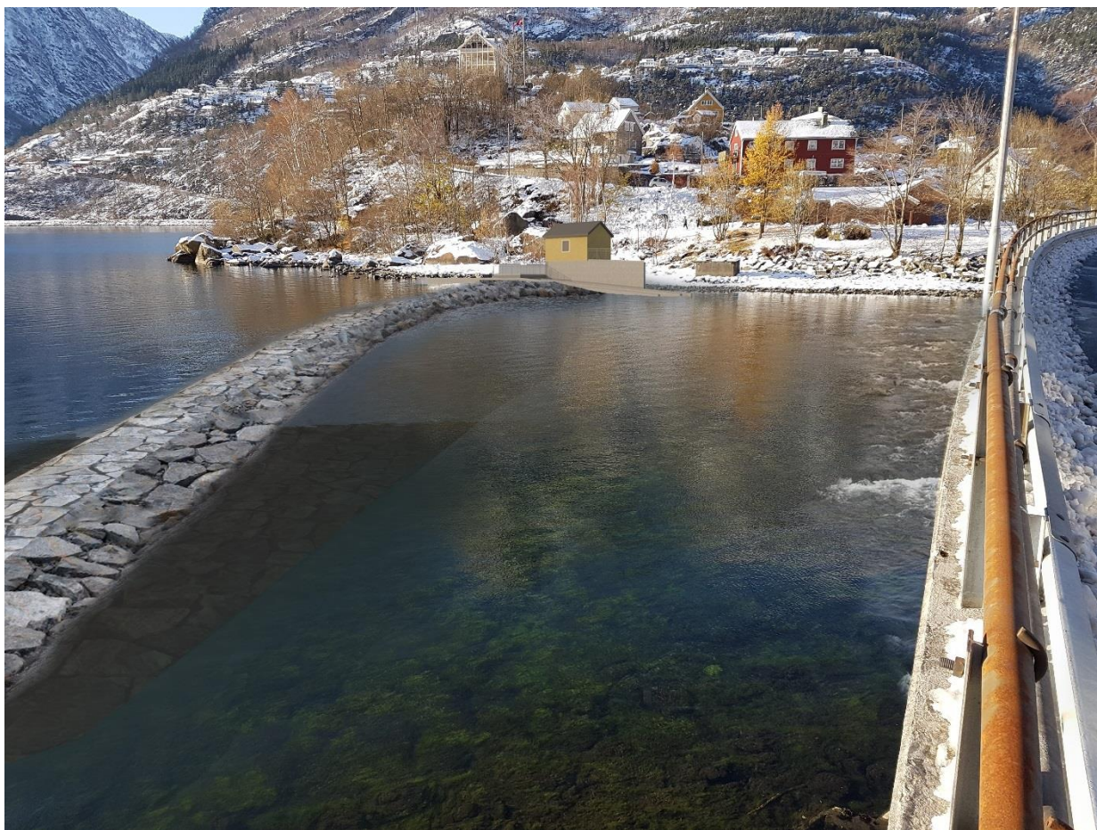
Figur 8-2 Illustrasjonen viser terskelen og lukehuset ved nordenden av Sandvinvatnet
