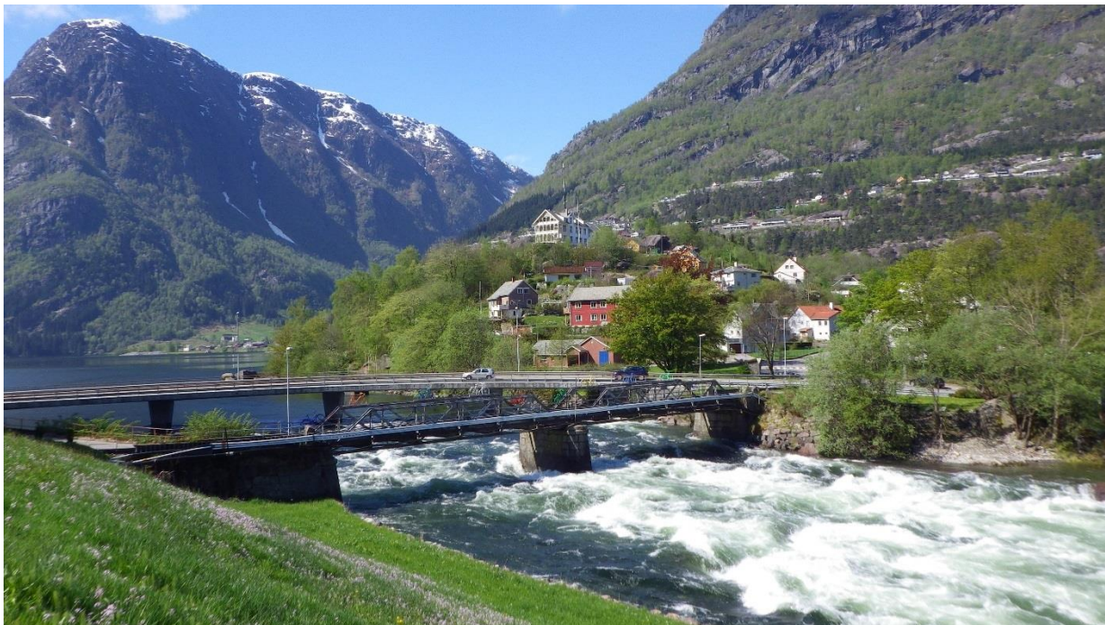
Figur 7-8 Bildet viser overgangen mellom Sandvinatnet og Opo 19.05.2017 med vannføring på 193\text{m}^3/\text{s} og vannstand på 88,03 moh
