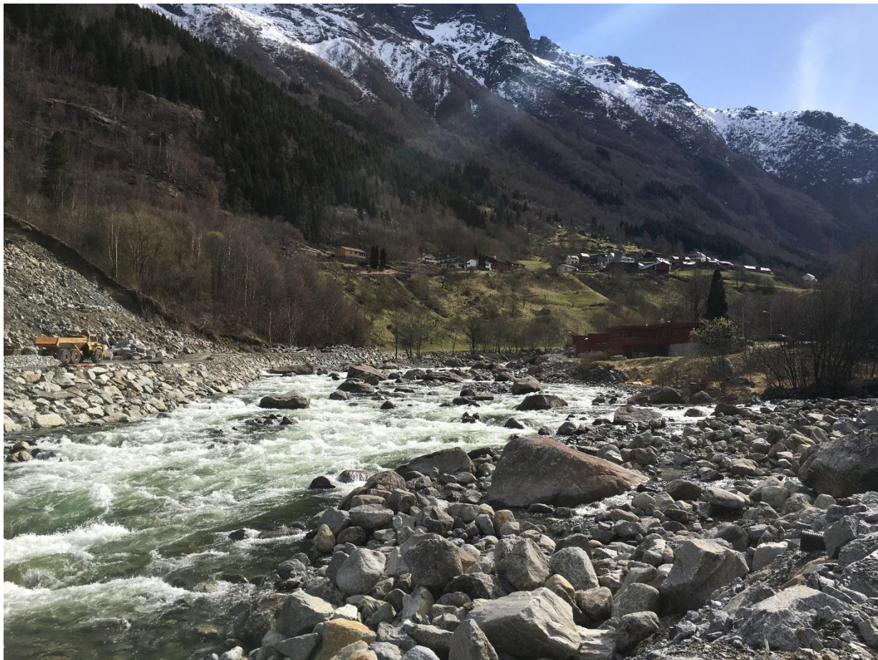
Figur 7-14 Bildet viser området ved Øyane 07.04.2017 med 33 m 3 /s vannføring. Skalaen i rommet er større enn Eidesfossen. Vannet fordeles over et større område og elveleiet fremstår med mye stein og relativt høye plastrete sider.
