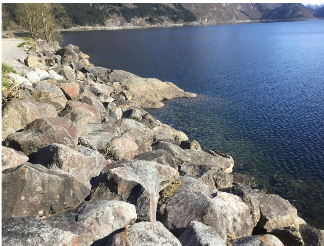
Figur 5-21. Det er gamle fyllinger og nokså brådypt utenfor Odda Camping der nytt deponi er planlagt. Foto: Finn Gravem.
