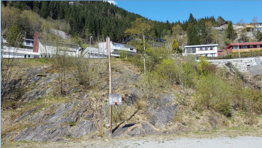
Figur 22: Adkomsttunnel ved Erreflot.
