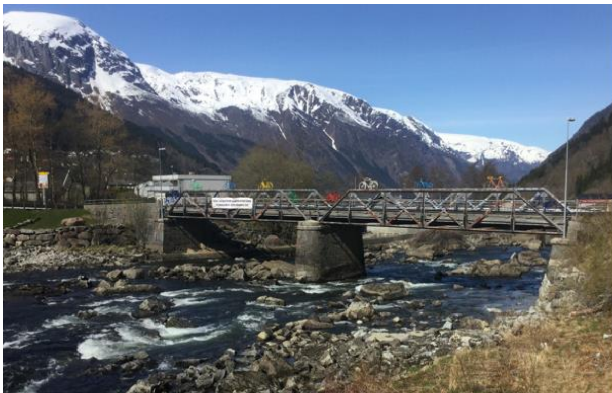
Figur 8-8. Gangbro ved Vasstun.
